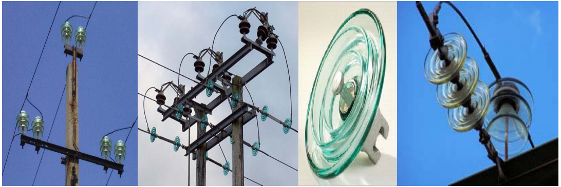
Şekil 3.2: Cam İzolatörler ve Uygulamaları
