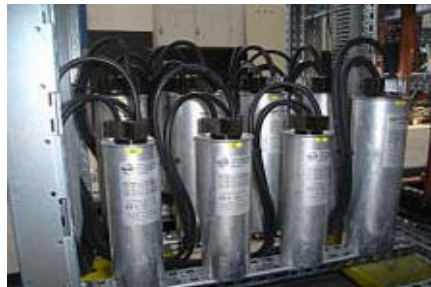
Şekil 4.13: Kompanzasyon Ünitesi
