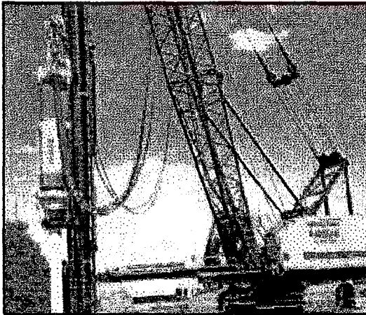
Şekil 3.1 Askı kılavuzu monte edilmiş mekanik vinç ile hidrolik çekicinin çalıştırılması
