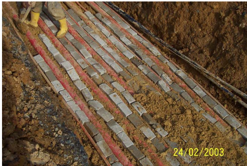
Şekil 2.1: Bedaş'ın TEİAŞ Maslak Şalttan Çıkan 35 kV Kablo Montajı – Kablolar Arası Tuğlalar.
