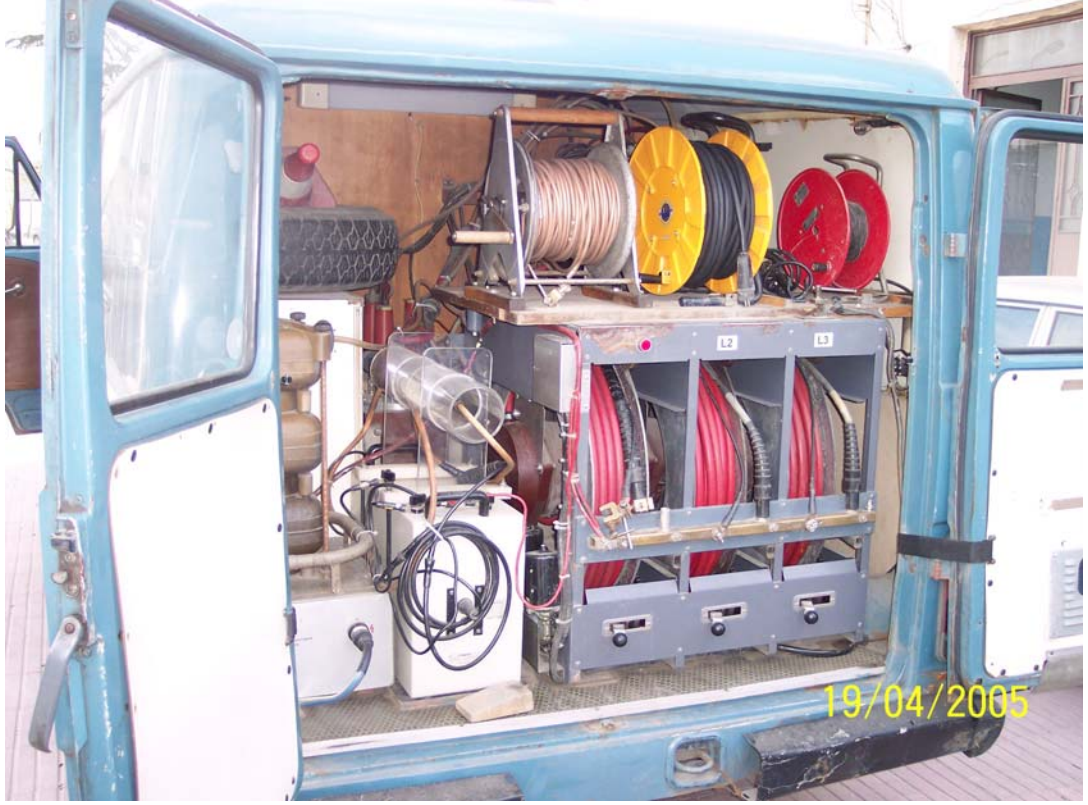
Şekil 2.21: BEDAŞ'ın Bir Kablo Test – Ölçü Aracının Arkadan Görünüşü.
