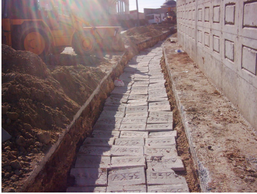
Şekil 2.2: Bedaş'ın TEİAŞ Maslak Şalttan Çıkan 35 kV Kablo Montajı – Kablo Koruma Plakaları.
