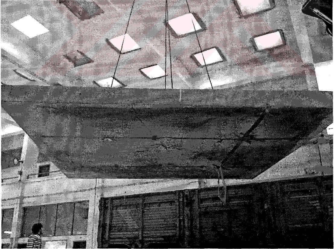
Şekil 5.21 P3 Plağının Alt Yüzeyinin Kırılma Sonrası Görünümü
