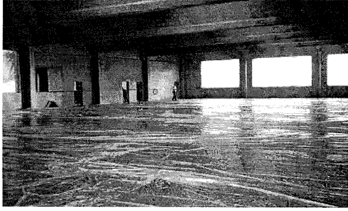
Şekil 2.6 Taze Bir Zemin Betonunun Korunması
