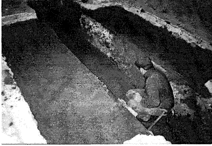
Şekil 3.4 Gro-beton Döküm İşlemi
