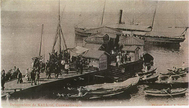
Şekil 4.16. 19.yy.'da yapılan eski ahşap Kadıköy İskelesi (Sebah ve Joaillier)
