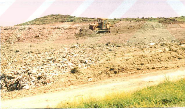
Şekil 6-7 Katı atıkların üzerinin killi toprak ile örtülmesi
