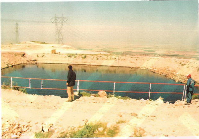
Şekil 6-8 Sızıntı suyu toplama havuzu
