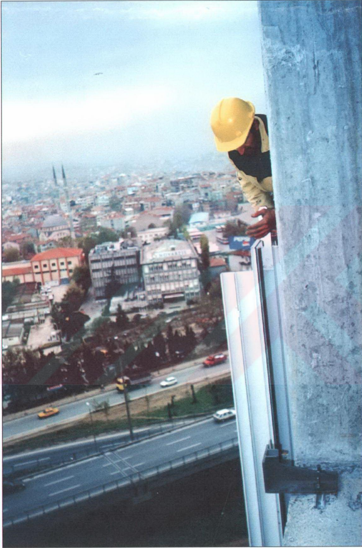
Şekil 6.24 İş Bankası Genel Müdürlük Binası Cephe Panellerinin Montajı
