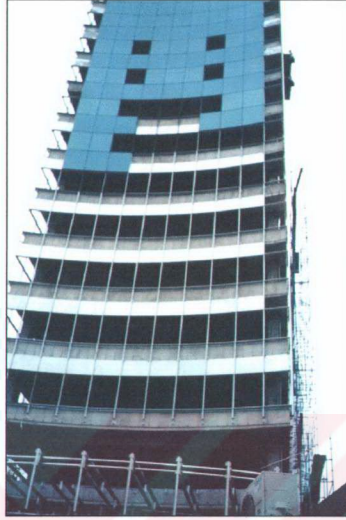
Şekil 6.29 I. Levent Plaza A Blok Cephe Panellerinin Monte Edilmesi
