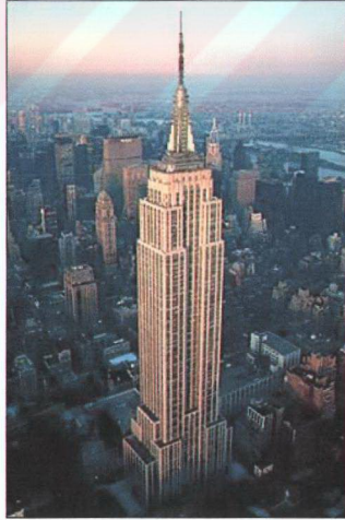
Şekil 2.4 Empire State Building [38]
