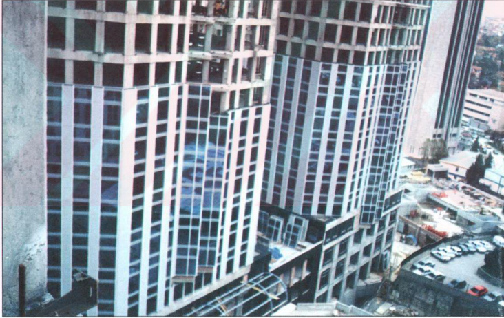
Şekil 6.23 İş Bankası Genel Müdürlük Binası Cephe Panelleri Yerleştirilirken
