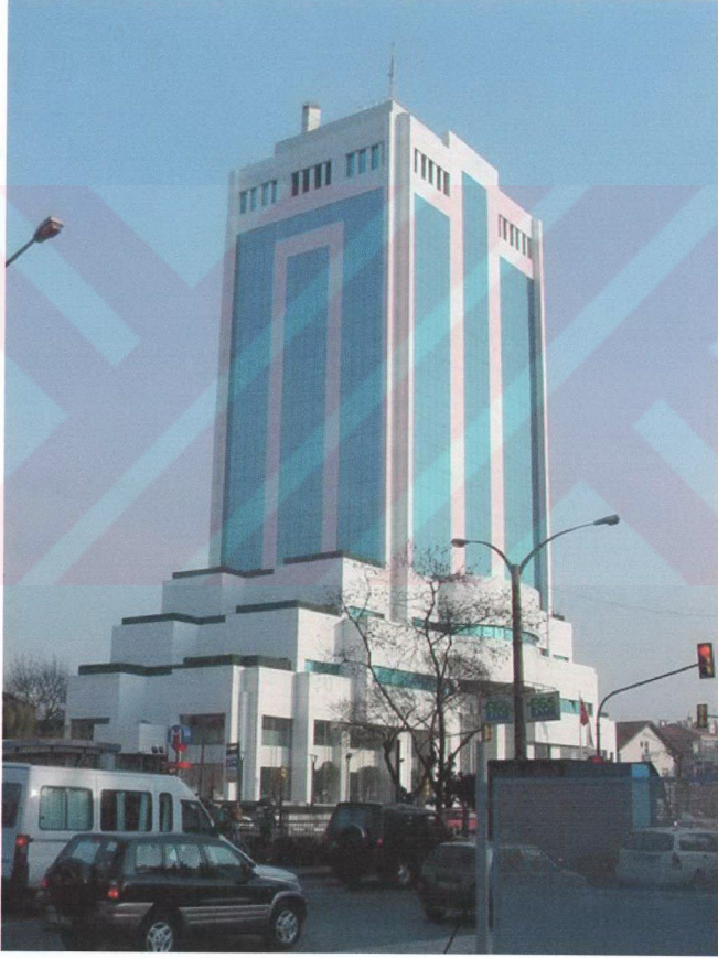
Şekil 6.33 Demirbank Genel Müdürlük Binası, İstanbul
