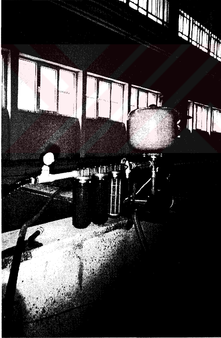
Şekil 4.3 Hidrofor pompa, filtre ve manometrenin gösterimi
