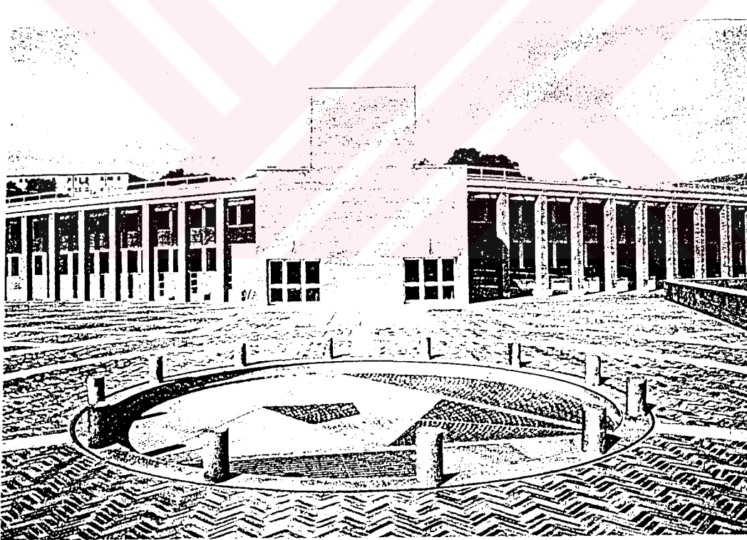
Şekil 5.16 : Gökyüzünde ışıkları temsil eden mozaik havuz suyun hareketiyle kırılarak durgun tuğla döşemeyi canlandırmaktadır. [44, s.32]
