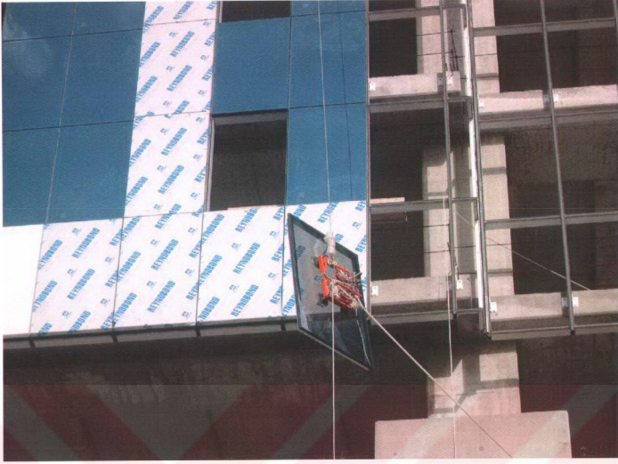
Şekil 5.8. Elektrikli vantuz ile cam montajı, Güney Plaza, Maslak, İstanbul
