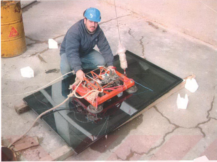
Şekil 5.6. Elektrikli vantuzun cam yüzeyine takılması, Güney Plaza, Maslak, İstanbul
