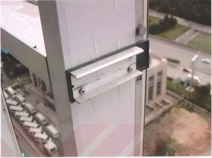
Şekil 6.2. Yatay kayıt conta uygulaması, Güney Plaza, Maslak, İstanbul
