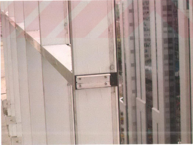
Şekil 5.4 Güney plaza giydirme cephesinde yatay kayıt uygulaması, Maslak, İstanbul
