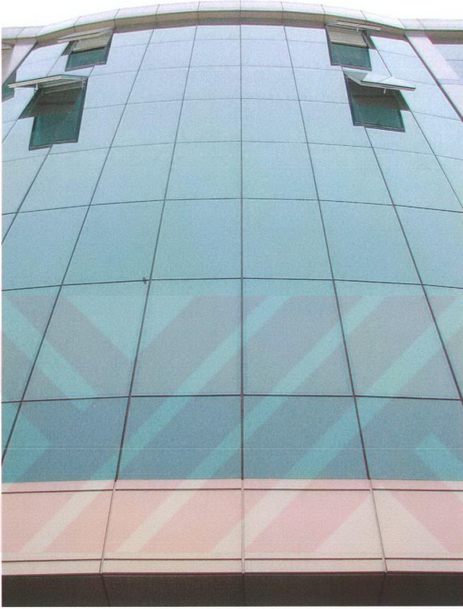
Şekil 3.7. Strüktürel Silikonlu Cephe sistemiyle yapılmış olan Belin Triko İş Merkezi, Ümraniye, İstanbul. [Fotoğraf: Nejdet ZİYAETTİN].
