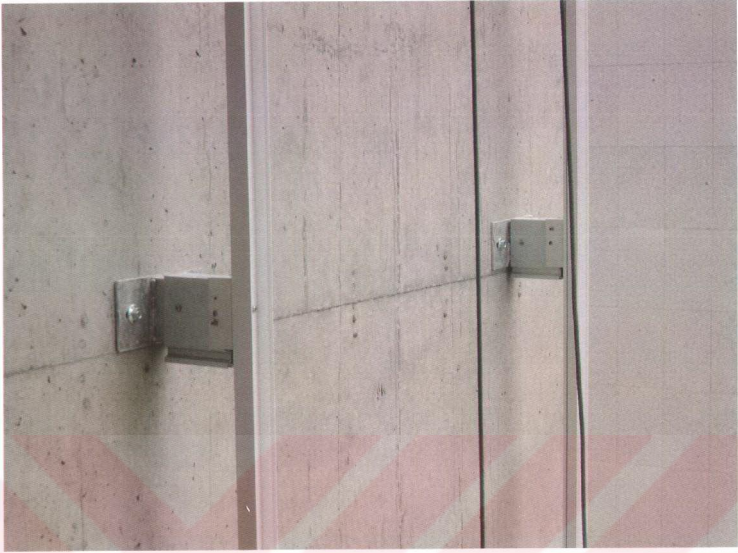
Şekil 5.10. Askılı sistem kompozit panel montajı, Güney Plaza, Maslak, İstanbul
