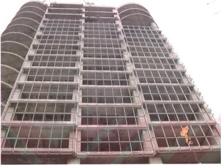
Şekil 5.5. Güney Plaza giydirme cephesinde dikme ve yatay kayıt montajı, Maslak, İstanbul. [Fotoğraf: Nejdet ZİYAETTİN].
