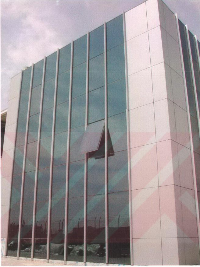
Şekil 3.5. Silikon Fugalı Silikon Cephe (Düşey Kapaklı Silikon Cephe) sistemiyle yapılmış olan Çebi Kilit Fabrikası, Sarıgazi, İstanbul [Fotoğraf:Nejdet ZİYAETTİN].
