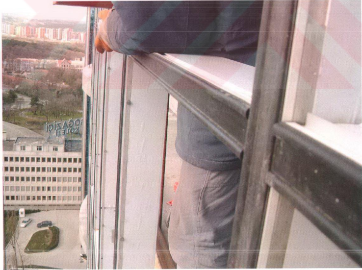
Şekil 6.3. Dikme ve yatay kayıt E.P.D.M fitil uygulaması, Güney Plaza, İstanbul
