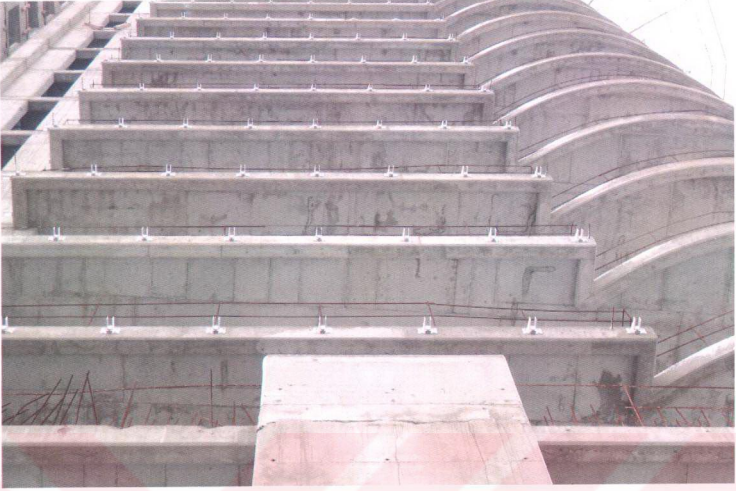
Şekil 5.1. Güney Plaza giydirme cephesinde ankraj montajı, Maslak, İstanbul.
