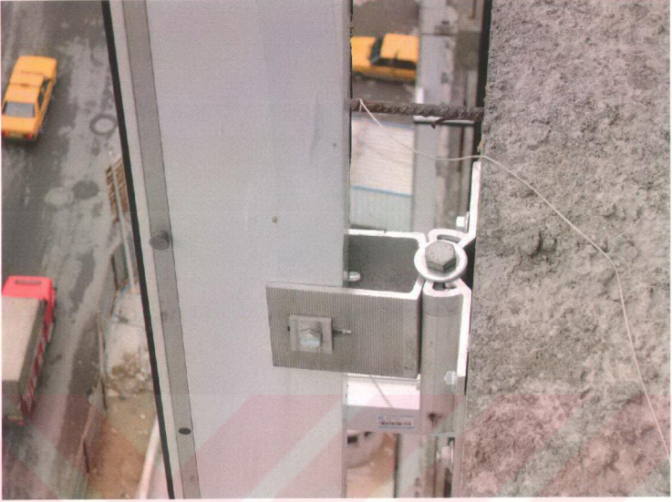
Şekil 4.5. Giydirme cephe düşey taşıyıcı elemanının ankraja tespit elemanlarıyla tutturulması ve bu sistemin yapıya çelik ankraj lamaları ile bağlanması. Güney Plaza, Maslak, İstanbul. [Fotoğraf: Nejdet ZİYAETTİN].
