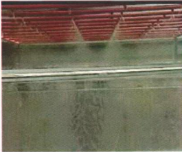
Şekil 7.4. Koni kare modelli hortum ağızlarının su püskürtmesi.
