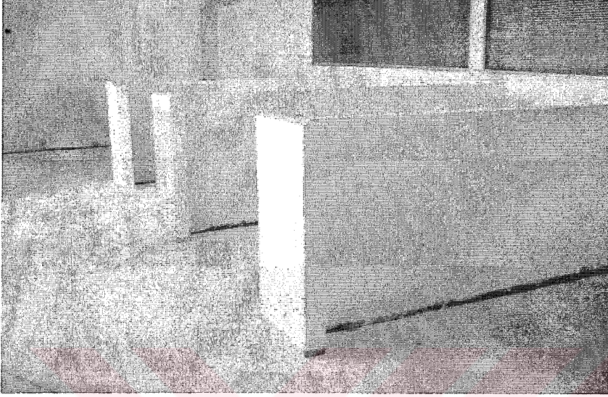
Şekil 5.6 Alçı levhalı bölme duvar uygulamaları
