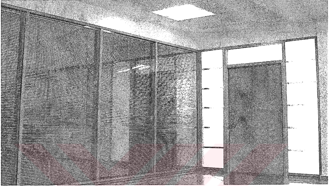
Şekil 7.5 Tugay Tekstil Ofis Binası Tavana Kadar Ayırıcı Bölme Duvarları 2 / ESENYURT
