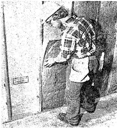
Şekil 6.1 Profiller arasına mineral yün uygulaması [9]
