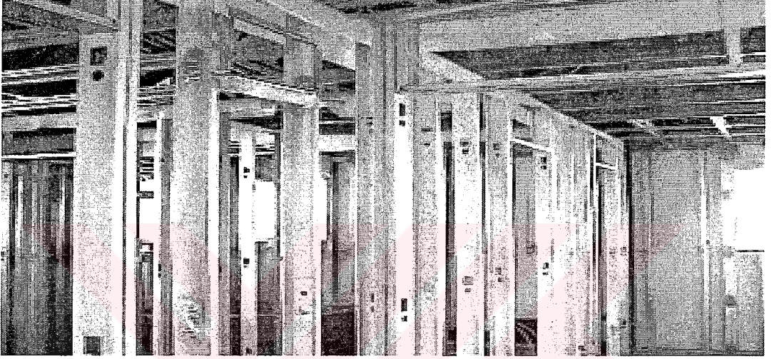
Şekil 4.22 Hafif çelik iç bölme duvarların taşıyıcı profilleri
