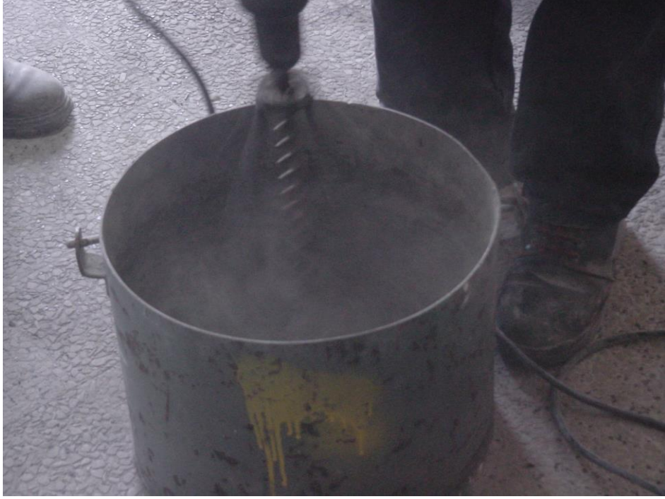
Şekil B.3 Agregalar, çimento ve silis dumanının kuru karıştırılması
