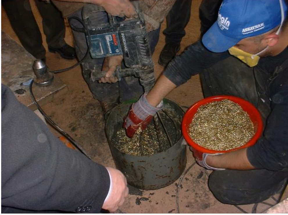
Şekil B.5 Karışıma Çelik Tel Eklenmesi
