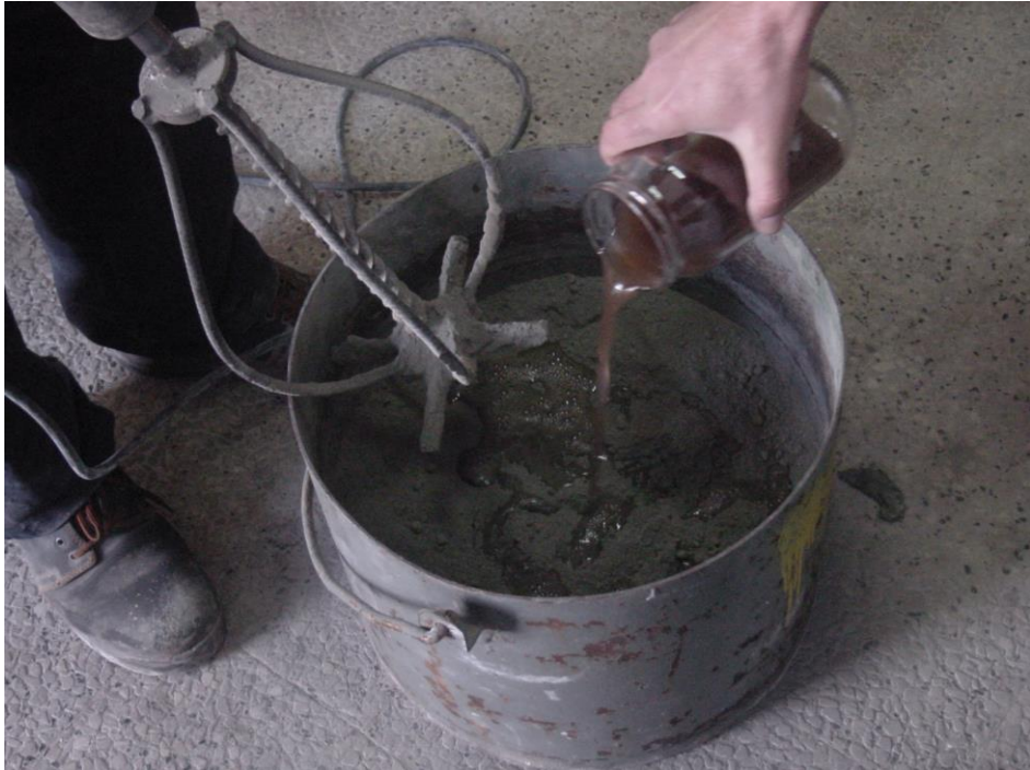
Şekil B.4 Süperakışkanlaştırıcı ve suyun ilk yarısının eklenmesi
