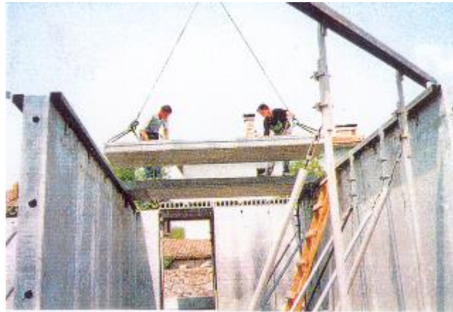
Şekil 4.8 Döşeme panelinin montaj iskeleleri ve duvar panelleri üzerine montajı
