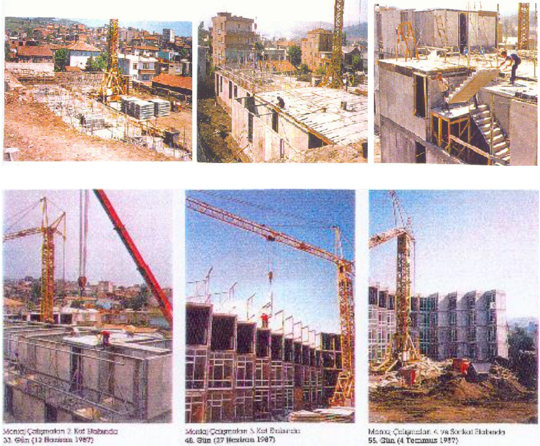
Şekil 4.9 Forap sistemi uygulama aşamaları
