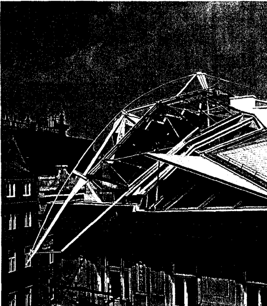
Şekil 3.22 Viyana'da bir tarihi binanın çatısı [31,sf:109]
