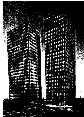
Şekil 3.3 Lake Shore Drive Apartmanları
