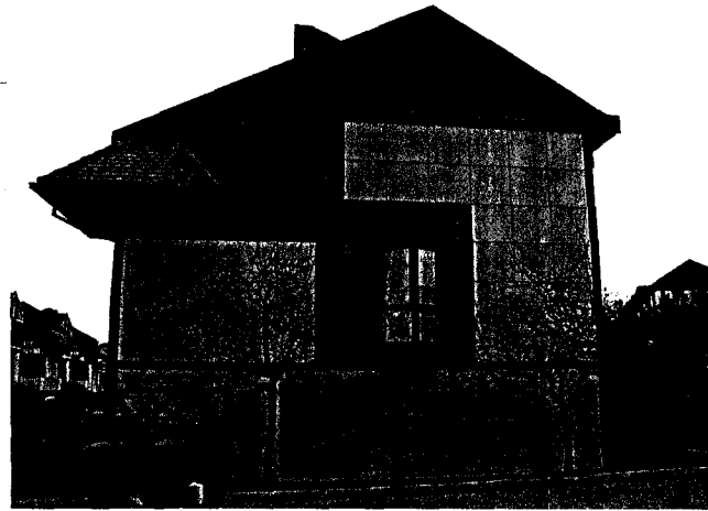
şekil 4.129 Yan cephe görünüşü [*)
