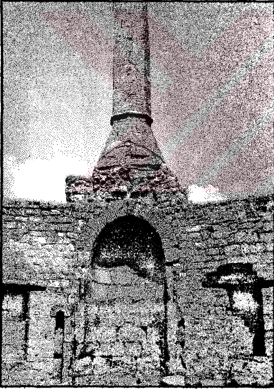
Şekil 4.10. Akyazılı Sultan tekkesi ocağı
