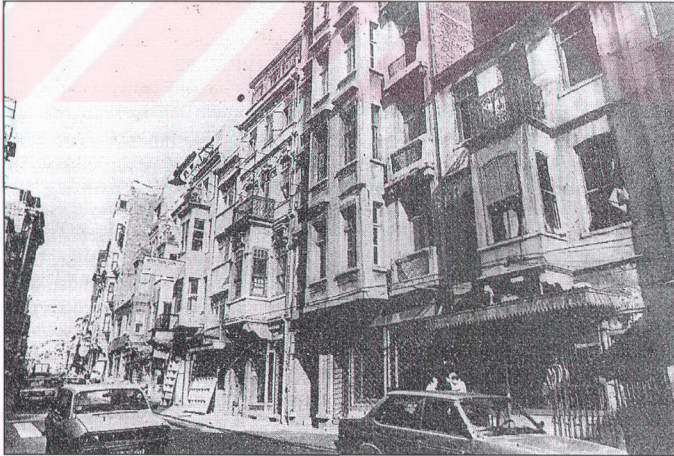
Şekil 4.7. Tarlabası Caddesi Yıkımdan Önceki Durumu (Ünlü, 2004)
