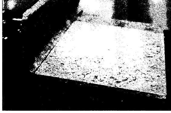
Şekil 3.29. Mantar döşeme kaplaması ve sıva dibi [3, s.337].
