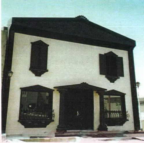
Mobilyacılar Sitesi Dükkan Cephesi, İstanbul
