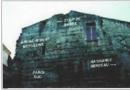
Şekil D-7: Bizans Hamamının güney Laconicum duvarı üstündeki izler.
