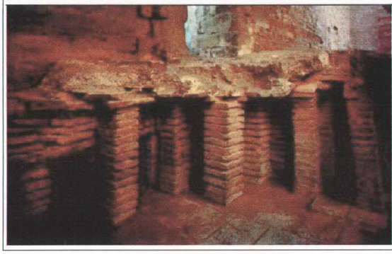
Şekil D-5: Bizans Hamamının bodrumunda yer alan temel duvar kalıntıları.
