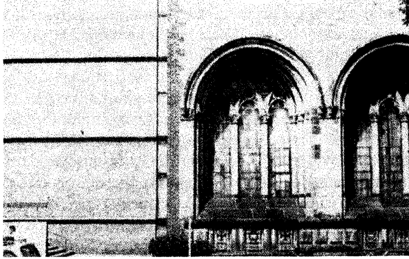
Şekil 5.1 Kahn, Yale Üniversitesi Ek Binası, 1950 [ 63 ]
