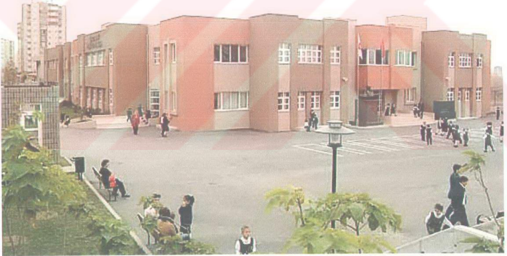
Şekil 4.13 Soyak Yenişehir'de Yer Alan Okul Binası (www.soyak.com.tr)
