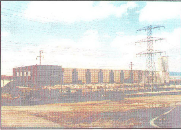
Şekil A.6. Artmar Fabrikası Görünüşü, (Mimar: Celalettin ÖZENÇ)
