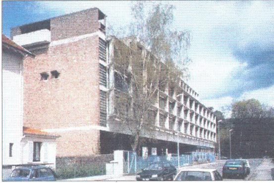
Şekil 4.19. Duval Fabrikası görünüş, Saint Dié 6
