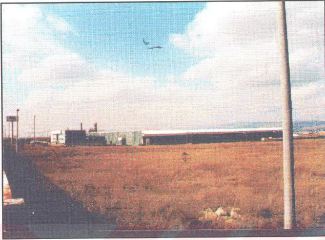
Şekil A.24. Pınar Süt Fabrikası Görünüşü (Mimar: OTAK)
