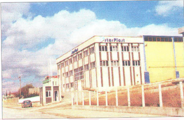
Şekil A.26. Starplast Fabrikası Görünüşü (Mimar: M. Zeki BARUTÇU)
