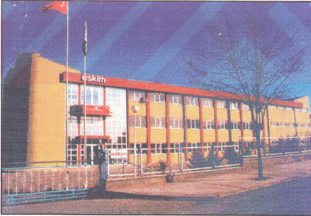
Şekil A.15. ESKİM Kimya Fabrikası İdare binası Görünüşü, (Mimar: İrfan KANIŞKAN)
