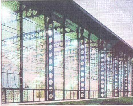
Şekil 4.45. Parkland Tekstil Fabrikası ön cephesi, Nottingham, UK (Soar, 1997)
