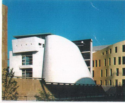
Resim 4.28. Batı kanadı konser salonu görünüşü
