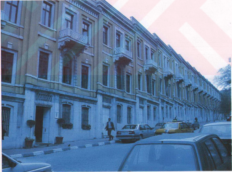
řekil 4.4 Akaretler Blokları, tamamlanmıř cepheler
