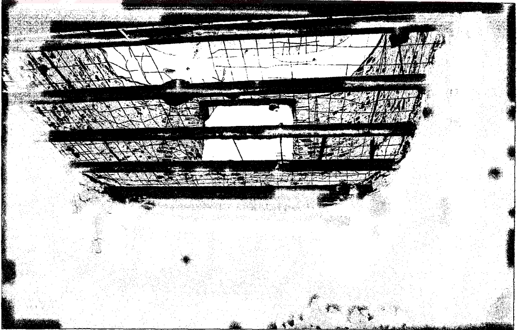
Şekil 4.26 Akaretler Blokları, döşemelerde korozyona uğramış elemanların yenilenmesi
