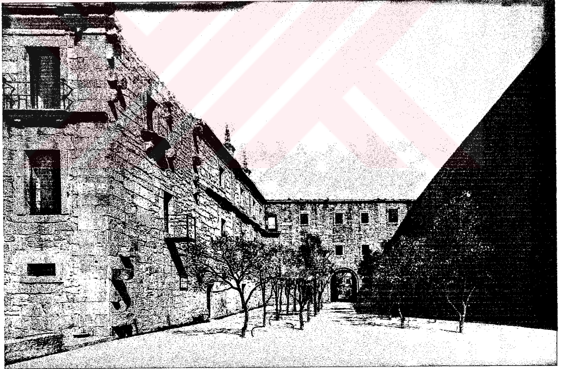
Şekil 3.4 Portekiz’de Braga yakınlarında yeniden düzenlenerek otel olarak kullanıma açılan bina
