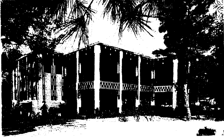
Şekil 4.13. Club Alda Tatil Köyü Binası'ndan Bir Görünüş.
