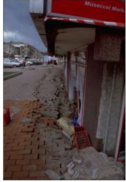
Şekil 3.84. Ze m inde oturma - Yalova
