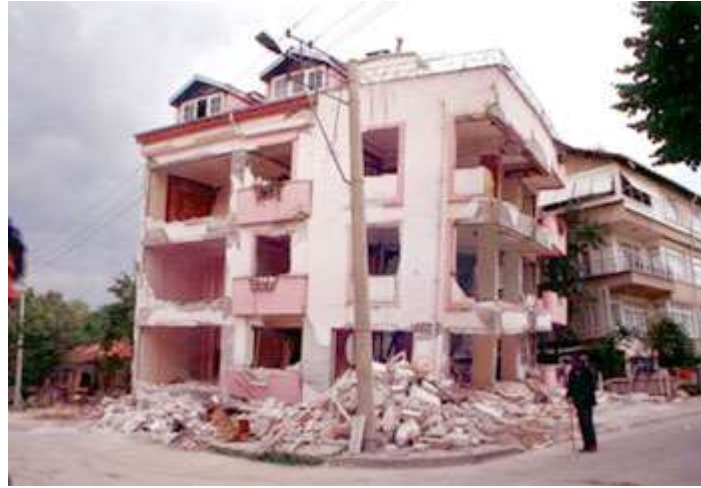
Şekil 3.61. Yanal rijitlik yetersizliği
