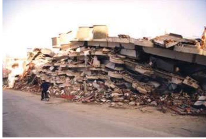
Şekil 3.59. Yatay ötelenme sonucu çöken bina
