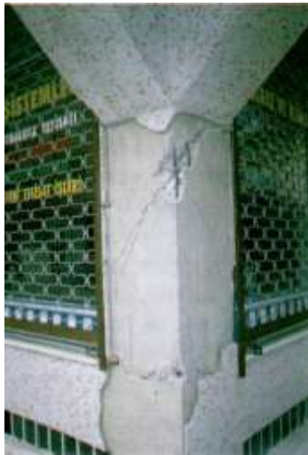
Şekil 3.31. Konsol ucunda kol onlu bi nada kay na çat la ğı
