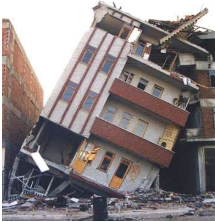
Şekil 3.74 Çekiçleme etkisi sonucu devrilen bina
