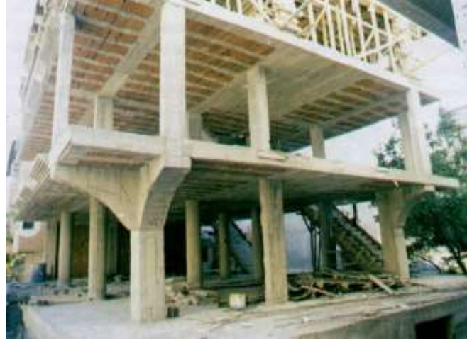
Şekil 3.30. Yapı m sür nekte olan konsol ucunda kol onlu bi na
