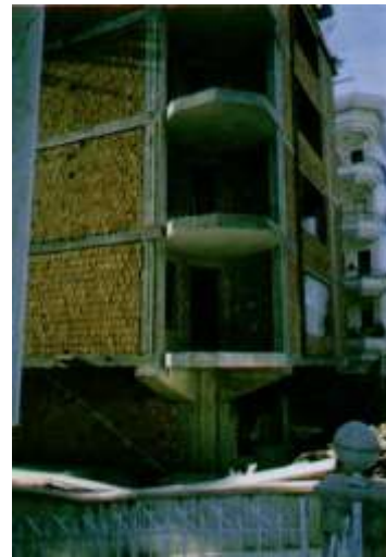
Şekil 3.32. Konsol ucunda kol onlu bi na
