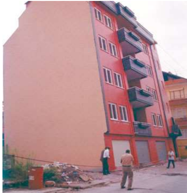
Şekil 3.81. Zeminde oturma
