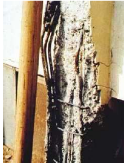
Şekil 3.87. Korozyon
