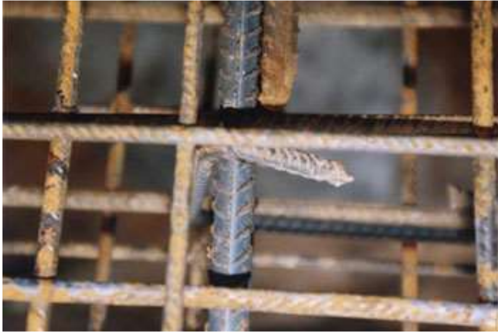
Şekil 3.68. Hriyede tamkanca örneği (135°)
