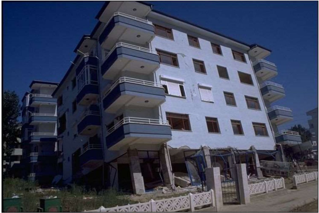
Şekil 3.26. Yuşak kat sorunu- Yalova
