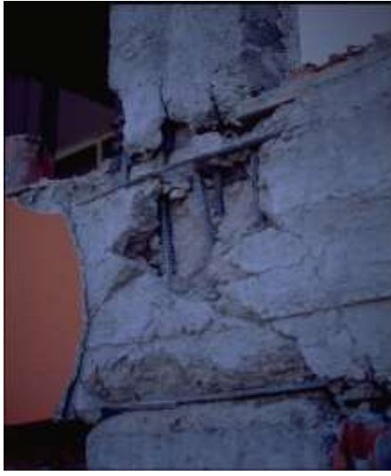
Şekil 3.47. Yetersiz enine donatı
