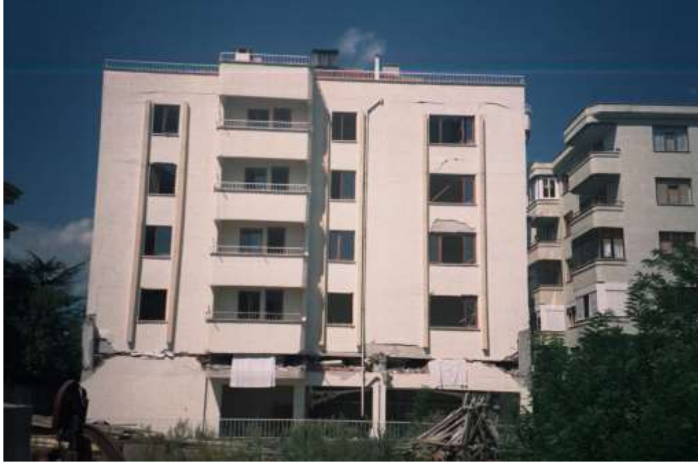
Ş ekil 3.27. A ra kat ın göç mesi durumu
