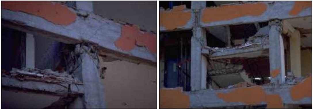
Şekil 3.37. Kısa kol on - Adapazarı
