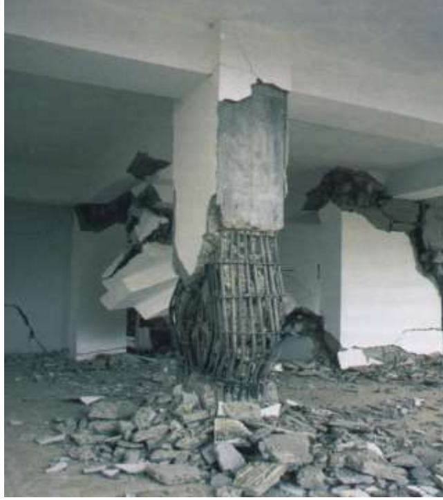
Şekil 3.45. Yetersiz enine donatı düzeni
