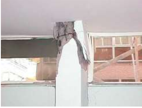
Şekil 3.54. Kolon başı mafsallaşma
