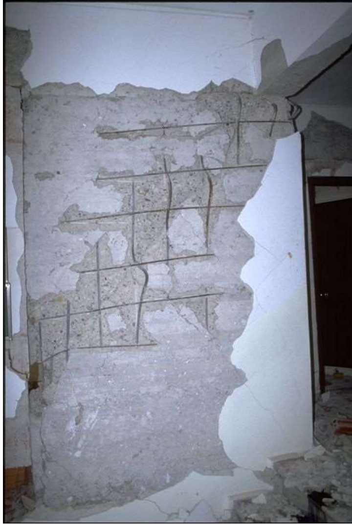
Şekil 3. 50. Boyuna donatı ve paspayı yetersizliği
