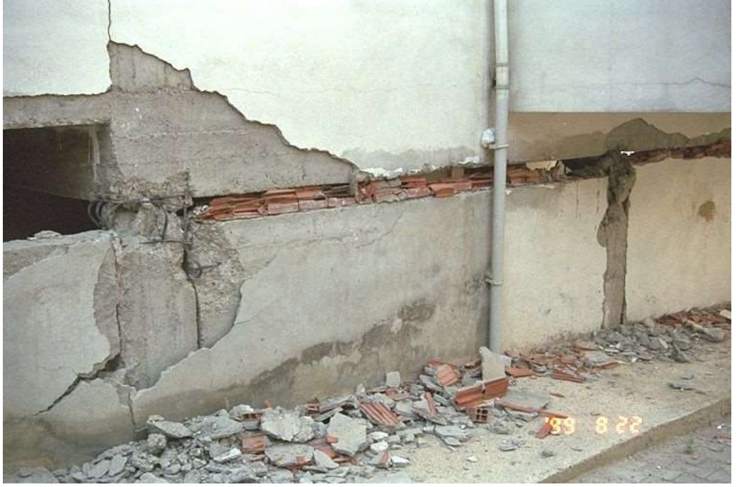
Şekil 3.38 Kısa kolon - Adapazarı
