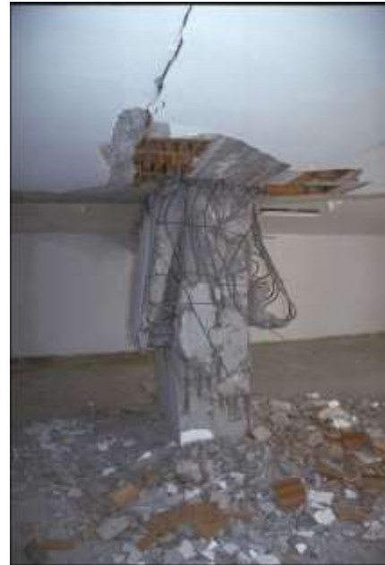
Şekil 3.42. Kolonda kesme hasarı-İzmit
