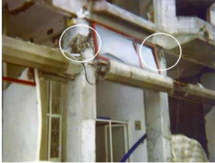
Şekil 3.39. Kısa kolon - Adapazarı
