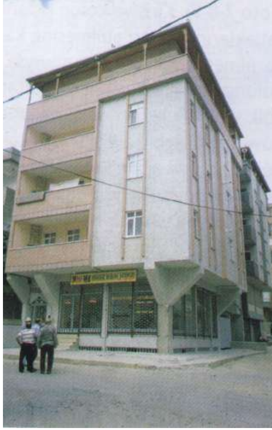
Şekil 3. 19. Düşeyde düzensiz bina örneği
