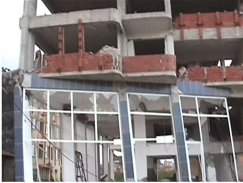
Şekil 3.25. Yuşak kat sorunu - Adapazarı
