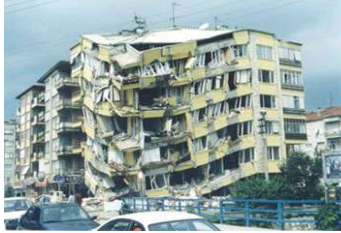
Şekil 3.82. Farklı oturma sonucu ağır hasarlı bina
