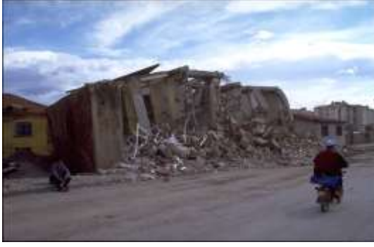
Şekil 3.75. Sıvılaşma hasarı
