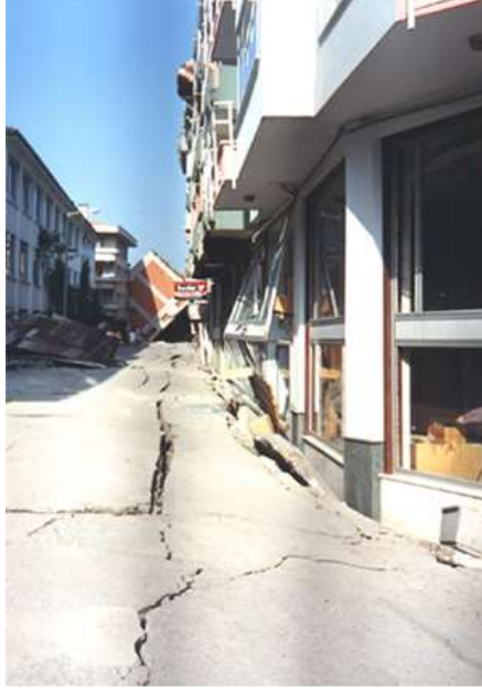
Şekil 3.83. Ze m inde oturma - Adapazarı
