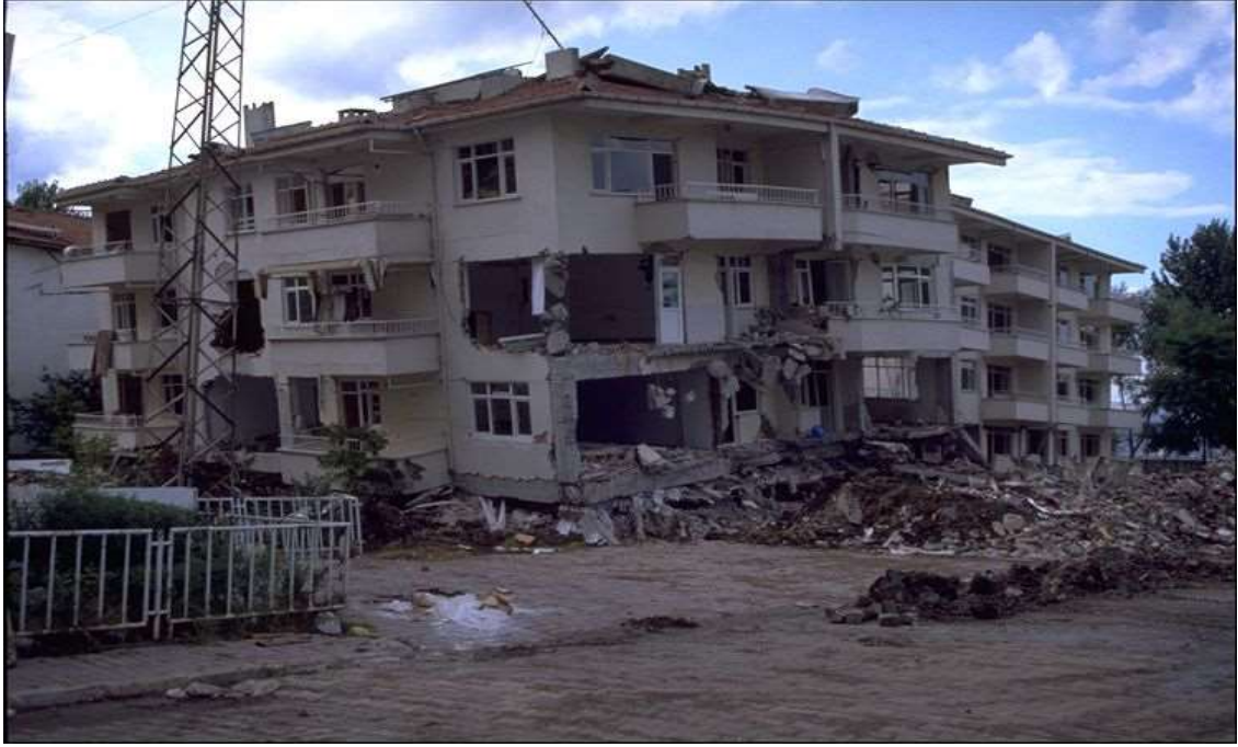
Şekil 3.24. Yuşak kat sorunu - İzmit
