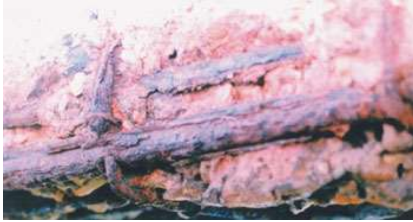
Şekil 3.89. Korozyon olayı
