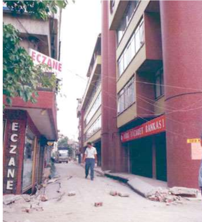
Şekil 3.85. Ze m inde oturma
