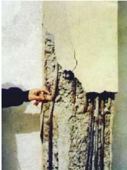
Şekil 3.86. Korozyon
