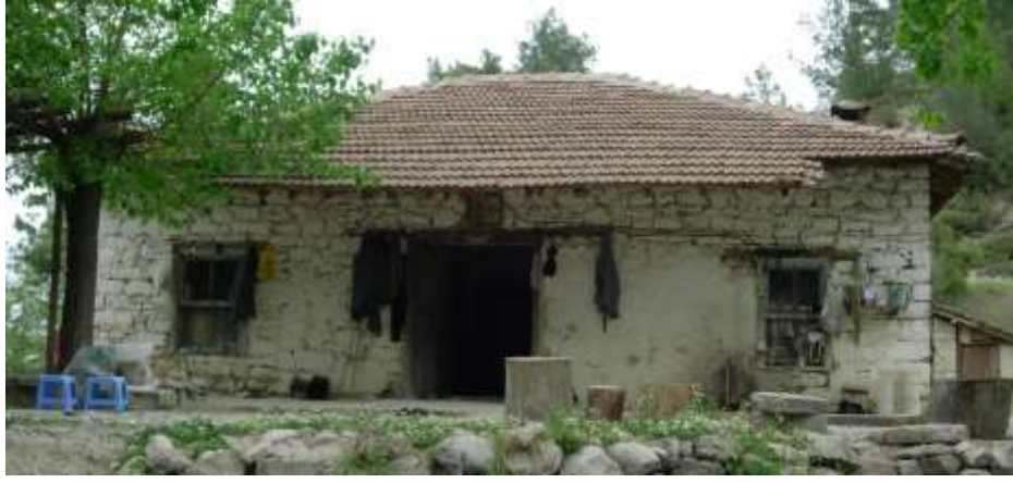
Şekil B1. Giriş Cephesi
