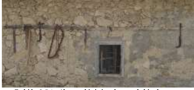
Şekil 6.21 Ahşap kirişin duvardaki durumu
