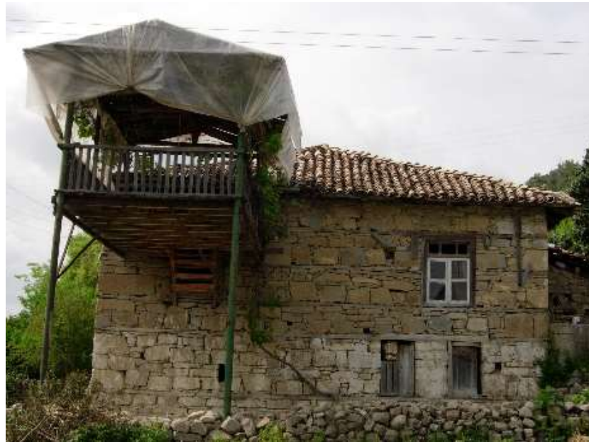
Şekil A2 sağ yan cephe
