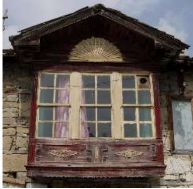
Şekil 6 11 Tavandaki ve ça ğnişirin üzerindeki ahşap işçili ği
