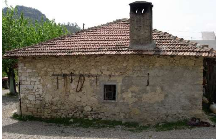
Şekil B3. sol yan cephe
