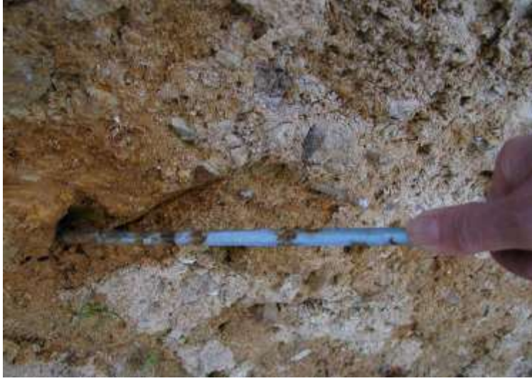
Şekil 4.19 Bitki köklerinin duvar diplerinde oluşturduğu oyulmalar
