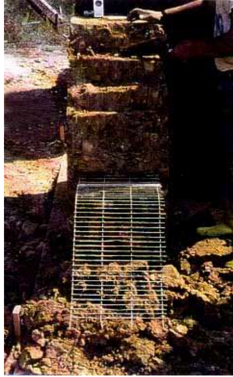
Şekil 4.7 Aker duvarlara yatay yüklere karşı hasır yerleştirilmesi [5]
