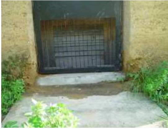
Şekil 4.14 Açılı kerpiç yapıda kapı kenarında aşınma
