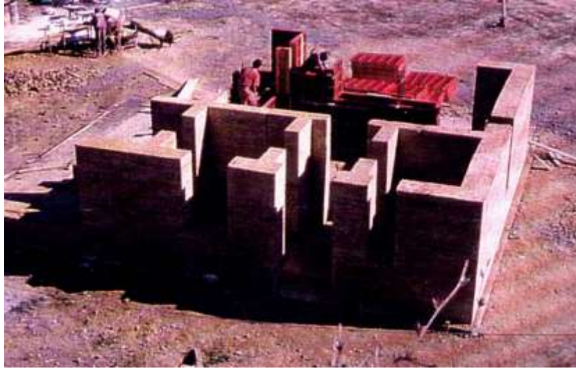
II. Akır (Açı kat kılı kerpiç) dene ne yapı sı, duvarları n yapı l nası [5]
