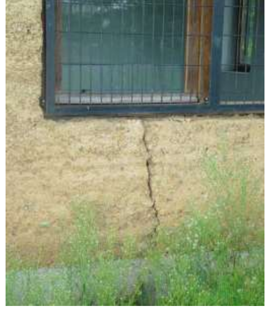
Şekil 4.8 Aker Duvar da ayrı dökülen bloklar arasında iş derzi oluşumu
