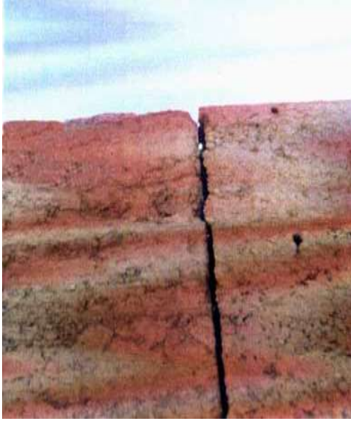
Şekil 4.8 Aker Duvar da ayrı dökülen bloklar arasında iş derzi oluşumu
