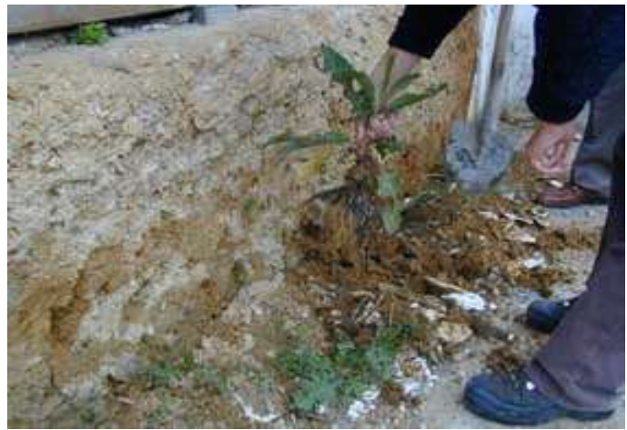
Şekil 4 18 Alçı yapıda bitkilerden kaynaklanan hasarlar
