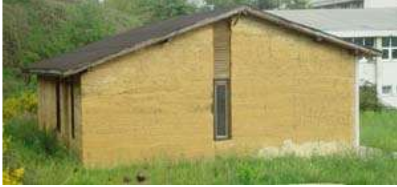
Şekil 4.5 -II. A ker (alçı katkılı kerpiç) dene me yapı sı batı b ör ünü ş ü
