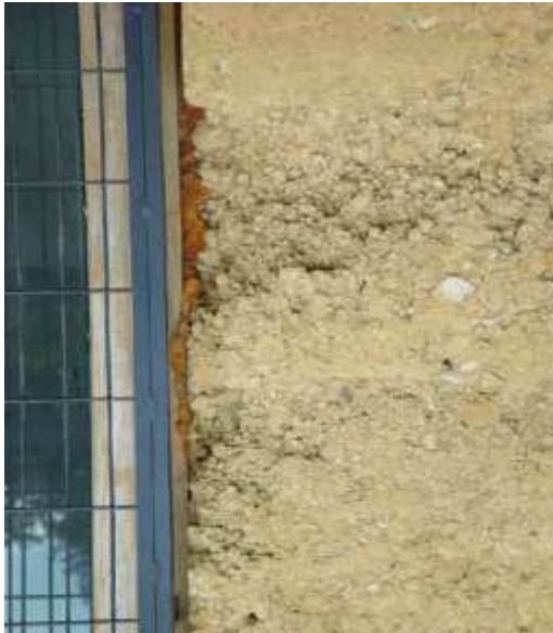
Şekil 4.20 Pencere kenarlarında görülen hasarlar
