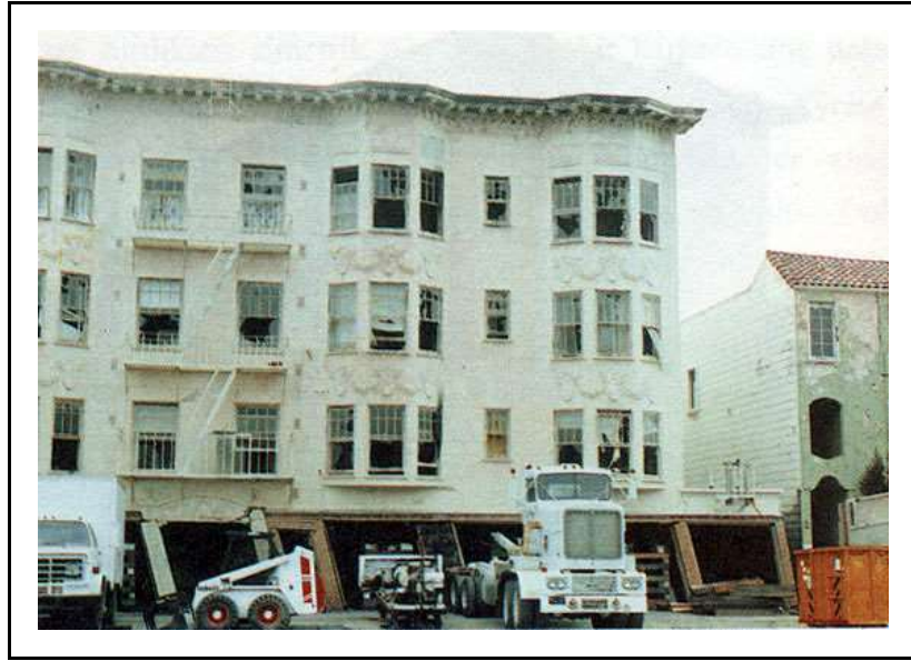
Şekil 3.12 1989 Loma Prieta depreminde yumuşak kat düşümü yüzünden hasar gören itfaiye binası
