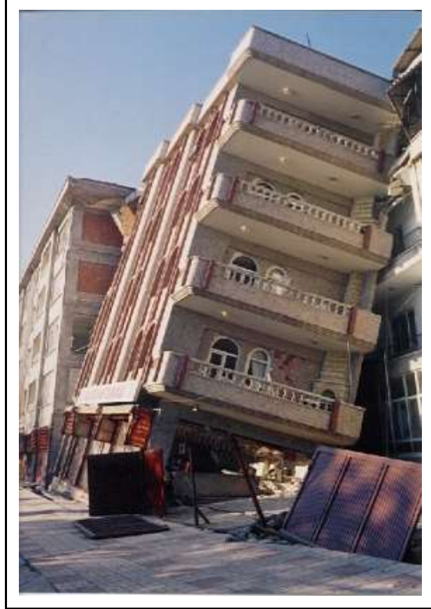
Şekil 3.17. G d d arı l amda yapı sal hasarı bul un maması nara ğ men zemin sı vı l a ş ması sonucu kullanı lamaz hale gel en bir b na
