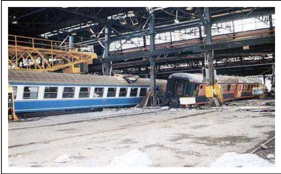
Şekil 5.6 Fabrika yapı sıyl a lirlkte hasar gören vagonlar
