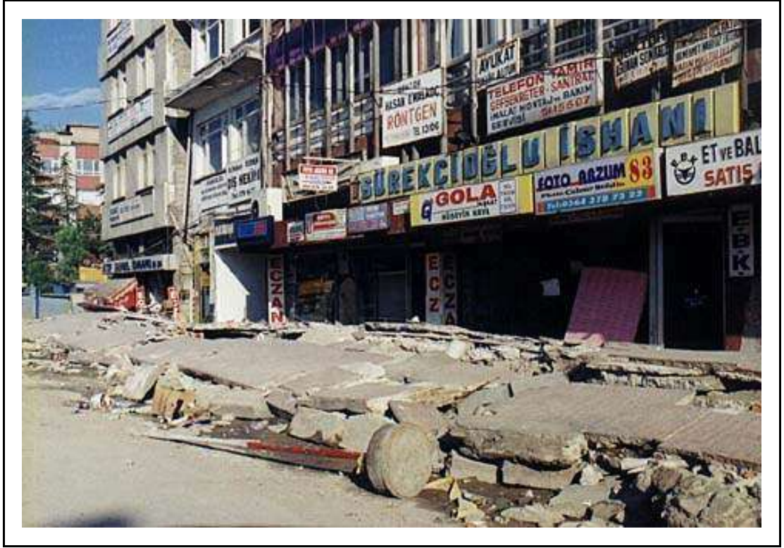
Şekil 2.4. Adapazarı'nda zemin sıvılaşması sonucu zemine batan bir bina
