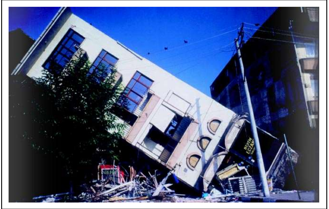
Şekil 2.3 Adapazarı'nda zeminin sıvılaşması sonucu devrilmiş bir bina
