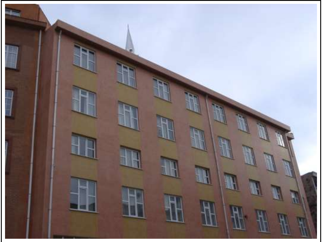
Şekil 3.13. Ara katlarından biri diğerlerinden daha düşük olan bir bina - İstanbul
