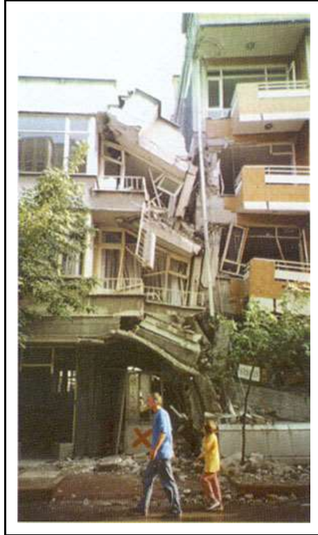
Ş e k i l 4.13. 1999 Gölcük depreminde, bitişik ri z a m d a i nş a edilmiş farklı kat yüksekli ğ ndeki yapıların çarpışmasıyla d u ş an hasar
