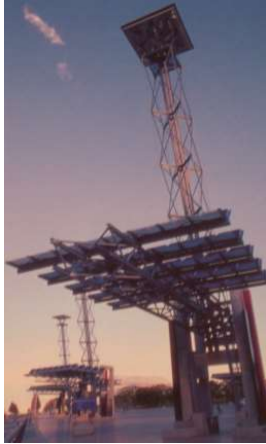
Şekil 3.3 Fotovoltaik güneş hücrelerinden oluşan, Olimpik Meydanı aydınlatma kulübü. (Sydney Organising Committee for the Olympic Games, Sydney Olympic Coordination Authority, 2001)
