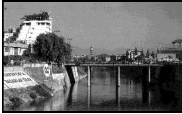
Şekil 4.2 Bugünkü Betonarme Köprü
