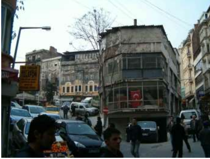
Şekil 5.21: Yıkılması Önerilen Bina
