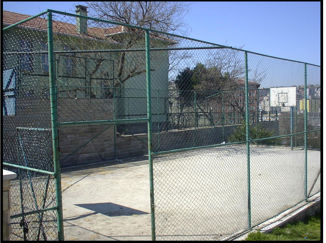
Şekil 2.6 : Bakımsızlıktan Kullanılamayacak Hale Gelmiş Basketbol Sahası
