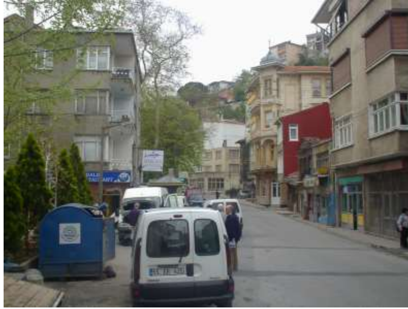
Fotoğraf 4.7 Yenimahalle Analiz Alanı Bina Örnekleri-2004
