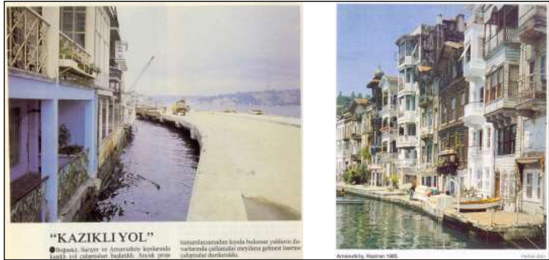
Fotoğraf 4.10 Arnavutköy Sahil Yolu Yapım Öncesi ve Yapımı Esnasında -1987 ( İstanbul Dergisi , S:2, 1993 )
