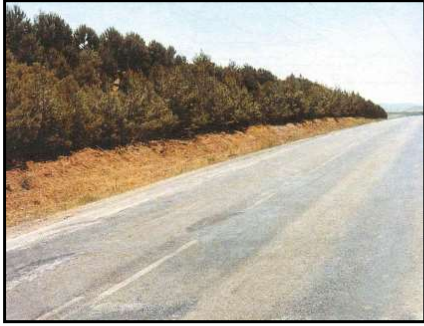
Şekil 3.19. Toprak stabilizasyonu ( Karayolu Bakım Kitabı, 1998)
