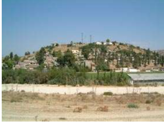
Şekil 4.43. Yamacına inşa edilmiş Karadağ işçi konutları
