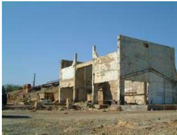
řekil 4.15. Madenin depolandığı beton strüktüre ait kalıntı
