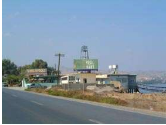
Şekil 4.12. Restore edil mesi öngörülen li man kontrol binası
