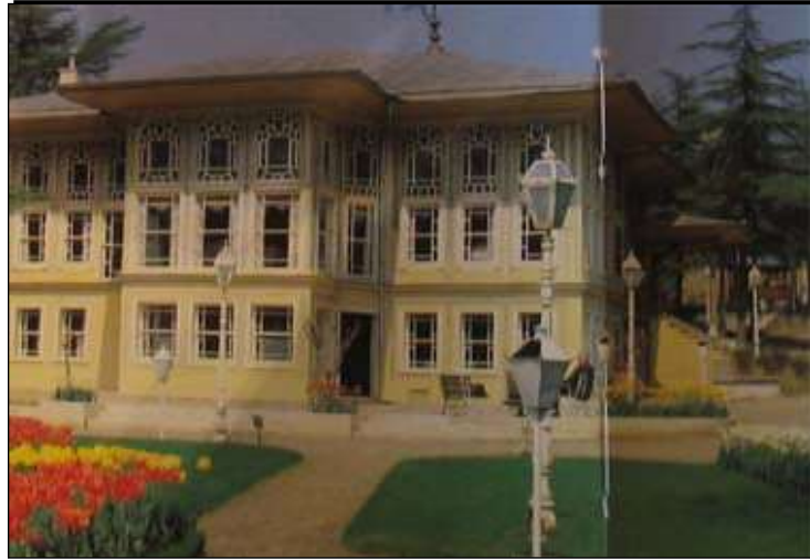
Şekil. 4 64 Aynalıkavak Kasrı bahçesinde kullanılan zemin döşemesi.
