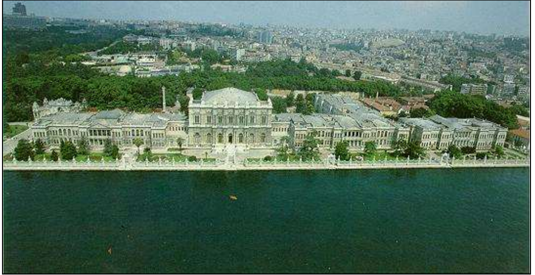
Şekil. 3.6 Dolmabahçe Sarayı yapılar topluluğunun genel görünümü.
