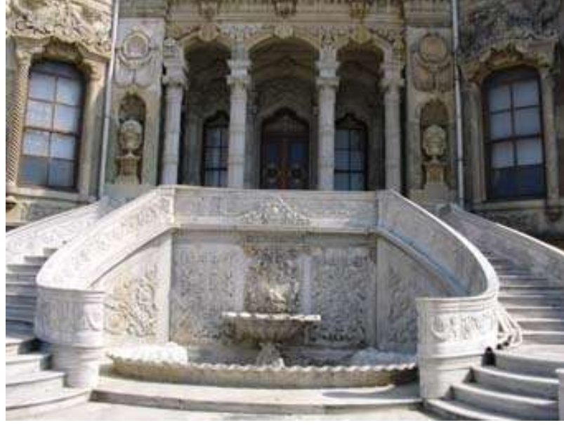
Şekil. 4 96 M e r d i v e n i n k ı v ı r ı k o l a r a k y a p ı l m ı ş s a ğ v e s o l k a n a t l a r ı a r a s ı n d a k a l a n s e l s e b i l l i h a v u z . ( K i ş i s e l Ç e k i m )
