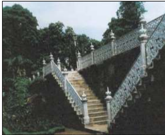
Şekil.4 40 Etkisel formu demir ağlardan oluşan merdiven korkulukları. ( Kişisel Çekim)
