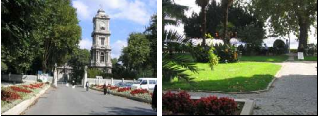
Şekil. 4 1. Soldaki resim Dolmabahçe Sarayı'nın Kabataş yönündeki iki tarafı begonya çiçekleriyle düzenlenmiş girişi ve II. Abdülhamit zamanında yapılmış olan Saat Kulesi. Sağdaki resim bahçe girişinde ziyaretçilere hizmet eden çay bahçesi. ( Kişisel Çekim)
