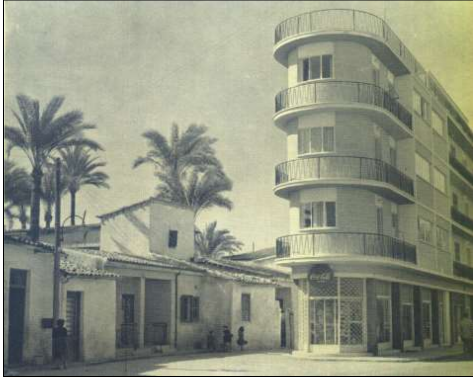
Şekil 2.16 İngiliz Dönemi'nde inşa edilen betonarme apartman örneği (1959). [13, s. 5]
