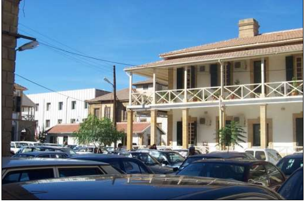
Şekil 2.26 Mhke ne binaları iç avlusundan görünümü.
