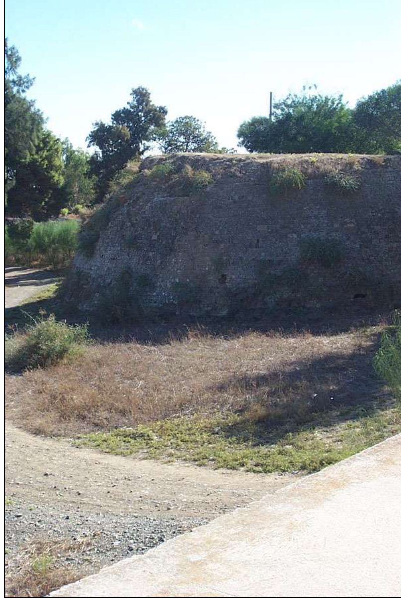
Şekil 2.29 Surlar (restorasyondan önce).
