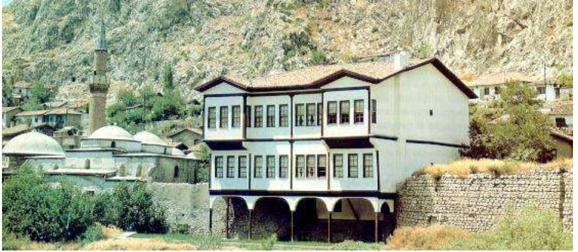
Şekil 3.10: restorasyondan sonra Hazretler Konağı ( http://dl.as.geo.cornell.edu/people/seber/pictures.html )
