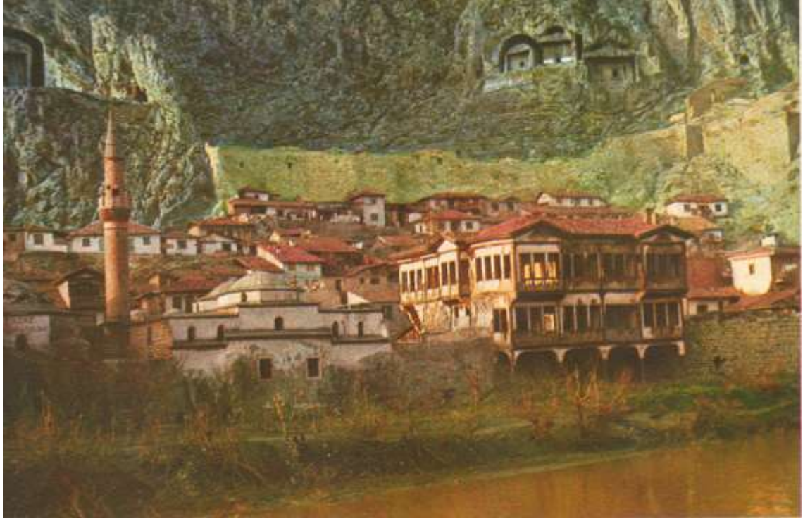
Şekil 3.9: Hazretler Konağı'nın restorasyondan önceki durumu (Tayla, 1977)
