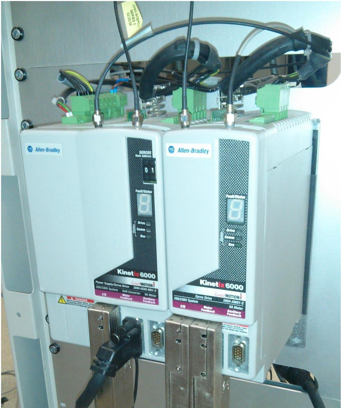
**Figure 1.6 : Allen Bradley Kinetix 6000**
