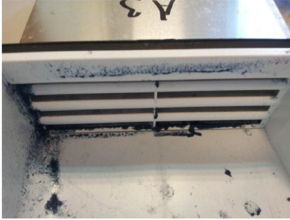
Şekil 3.7 : Yıkama öncesi ve sonrası kondenser girişi görünüm.
