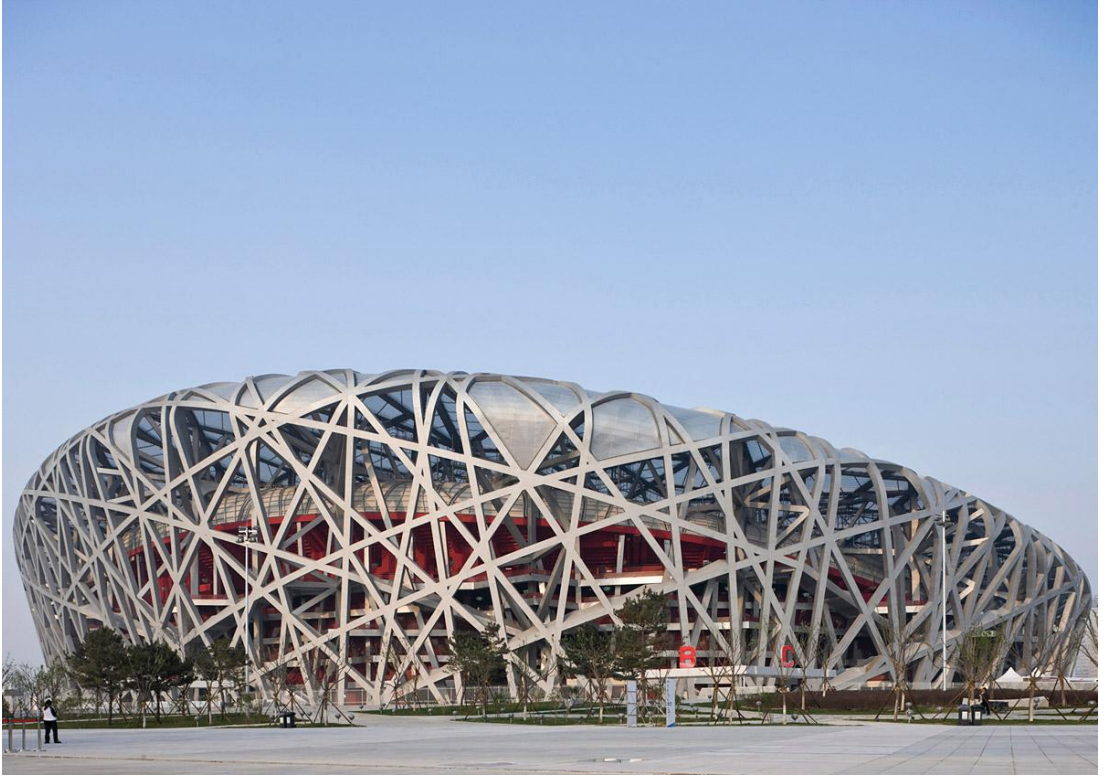
Şekil 4.22 : Bird's Nest'in cephe strüktürü kurgusu (Url-14).
