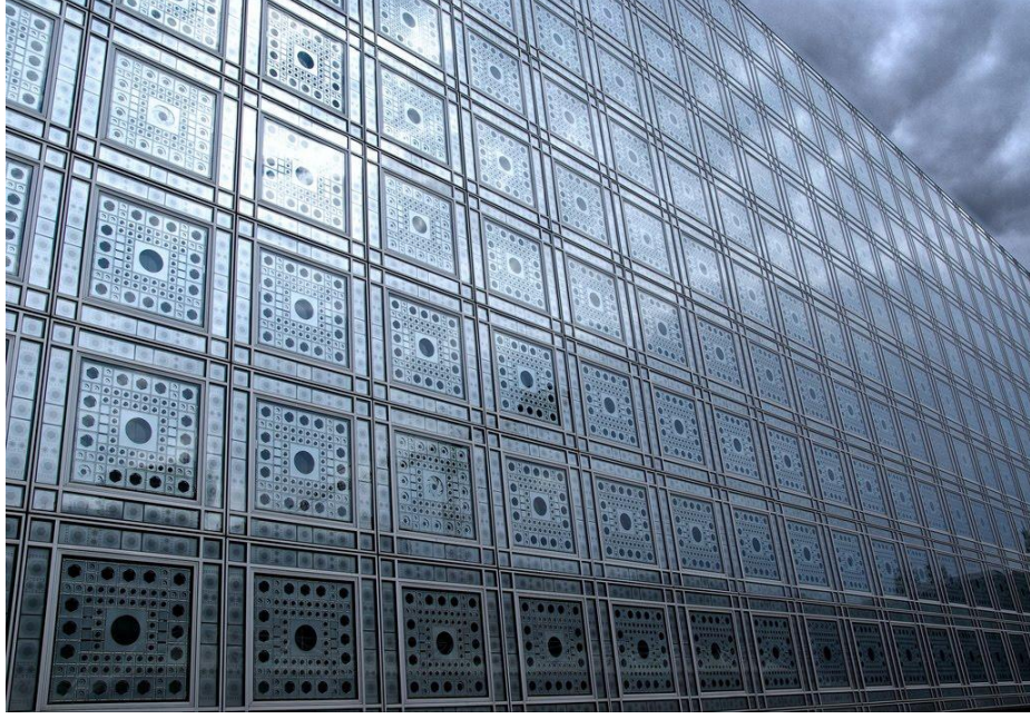
Şekil 2.10 : Mimar Jean Nouvel'in Paris'teki Institut du Monde Arabe'nin fraktallere dayalı cephe kurgusu (Url-20).
