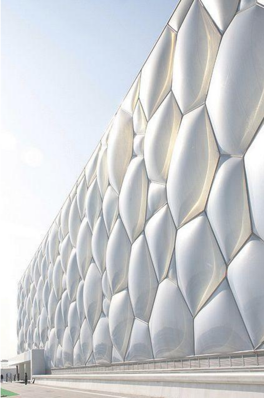
Şekil 4.16 : Water Cube'un cephe kurgusunun sokaktan görünüşü (Url-9).
