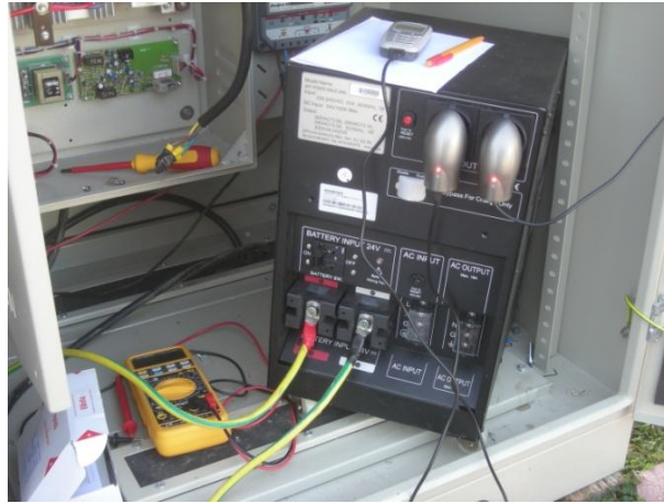
Şekil 3.13 : Donanım dolabında yer alan inverter.
