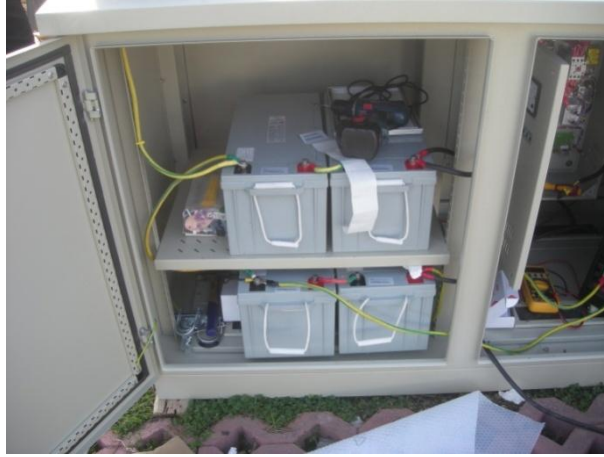
Şekil 3.14 : Donanım dolabında yer alan akü grubu.
