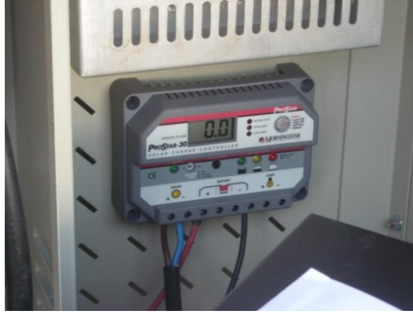
Şekil 3.12 : Donanım dolabında yer alan şarj kontrol ünitesi.
