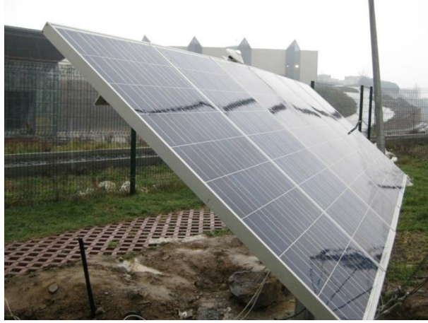
Şekil 3.3 : İTÜ meteoroloji parkına kurulan 750 W' lık PV sistemi.
