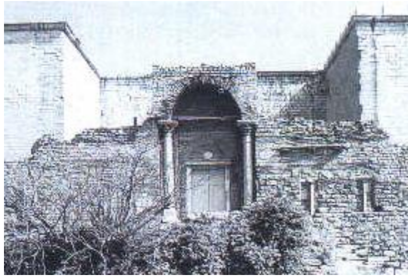
Şekil 3.5.2.1 Altın Kapı'nın kır kesiminden görüntüsü. 14.yüzyılın ikinci yarısında inşa edilen ön kapı ve iki yanda ana kapının iki kulesi görülmektedir. (Müler, 2002, s.300)
