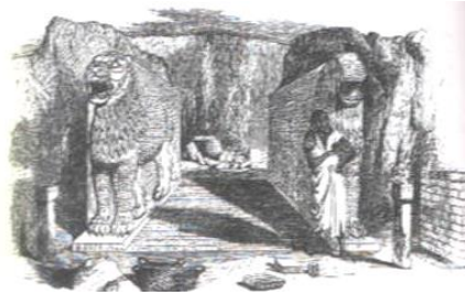
Şekil 2.2.3. Şarrt-niphi Şapeli girişi. (Sevin, 1991, s.146)
