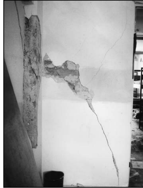
Şekil 3.9: Kesme çatlağı (Bingöl-2003) Şekil 3.10: Kesme çatlağı (Bingöl-2003)
