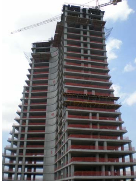
Şekil 1.1 : Çok katlı bir yapıda perde kullanımı.
