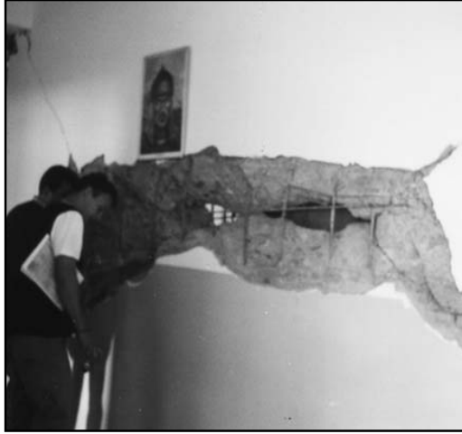
Şekil 3.7-Şekil 3.8 : Bingöl Lise Binası Perde duvarda kesme kırılması (1 Mayıs 2003 Bingöl Depremi).
