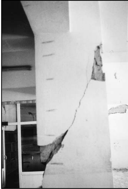
Şekil 3.9: Kesme çatlağı (Bingöl-2003) Şekil 3.10: Kesme çatlağı (Bingöl-2003)
