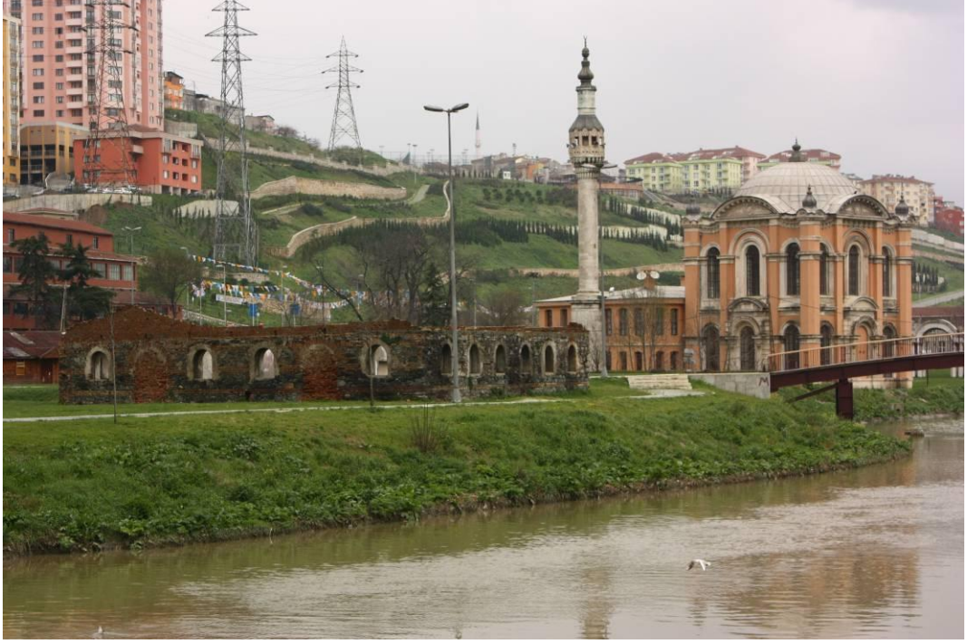
Şekil 4.41: Karakolhane Binası'na ait kalıntılar (Fotoğraf, kişisel çekim, 2008)
