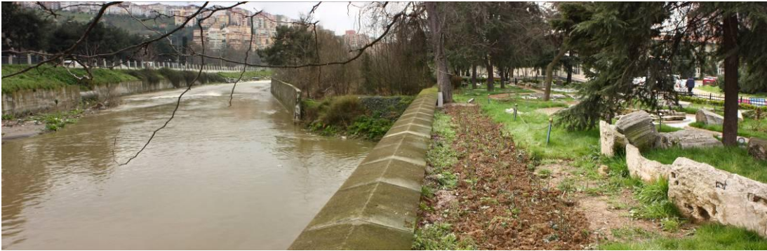
Şekil 4.67: Kanal ve havuzların birleşim noktası, 2009 yılı (Kişisel çekim)
