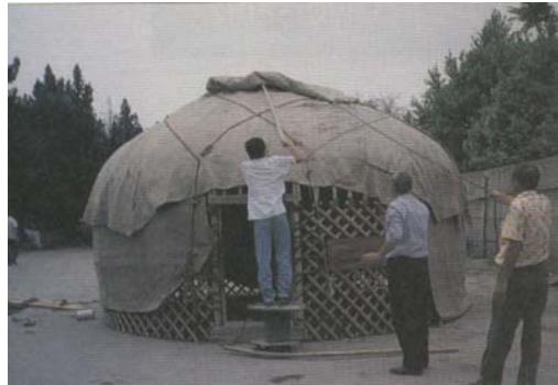
Şekil 4.2 Kurulmakta olan bir yurt çadırı
