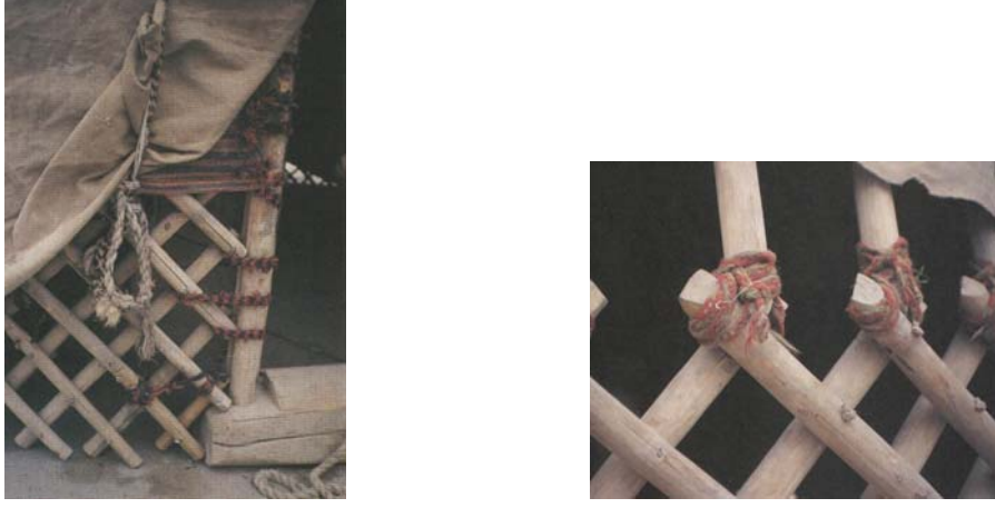
Şekil 4.1 Yurt çadırlarının bağlantı detayları
