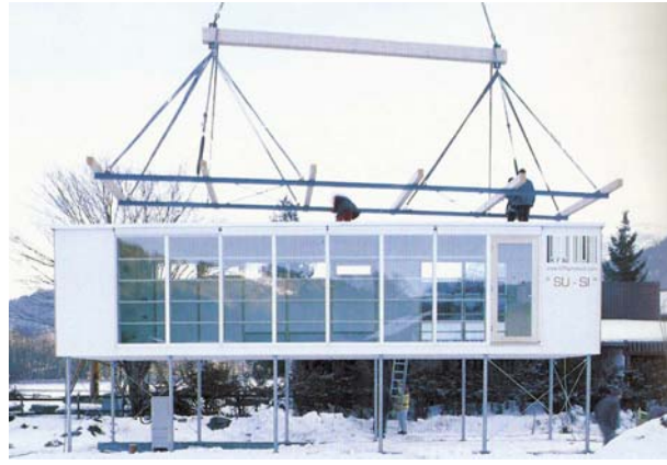
Şekil 2.33 Mobil vinç yardımıyla kurulan Su-si Birimi
