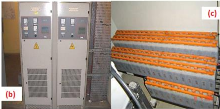
Şekil 3.8 : (a) Batarya şarj devresi. (b) BCB panosu. (c) Ni-Cd bataryalar.
