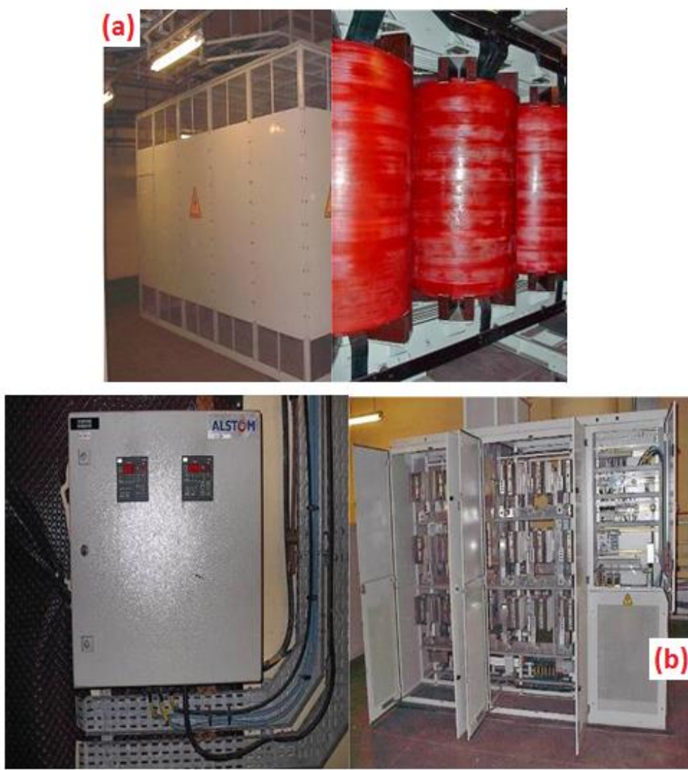
Şekil 3.5 : (a) Redresör trafosu. (b) Doğrultucu ünitesi.
