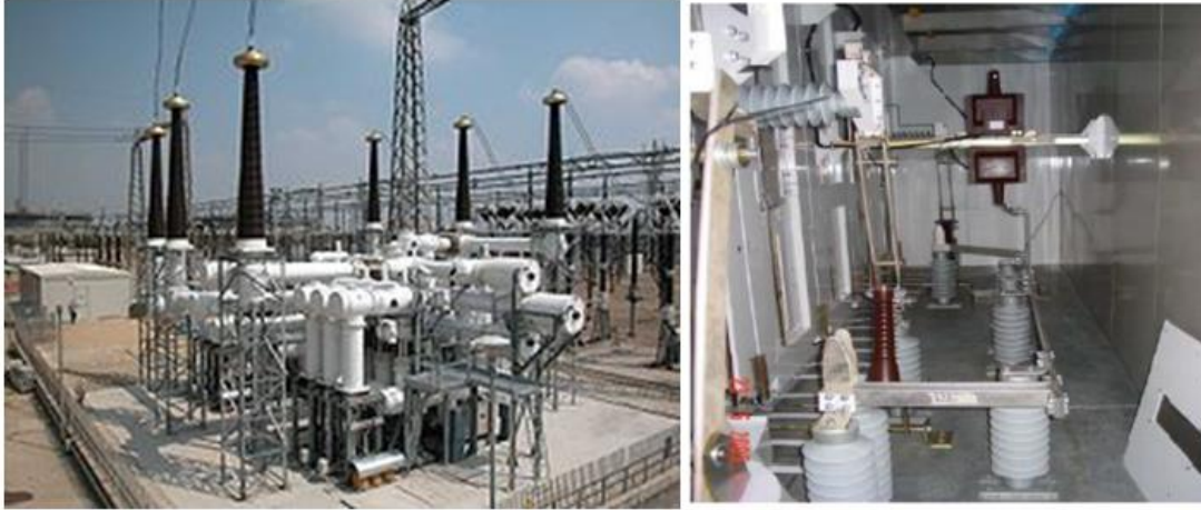
Şekil 2.20 : Hava izoleli AC kesiciler.
