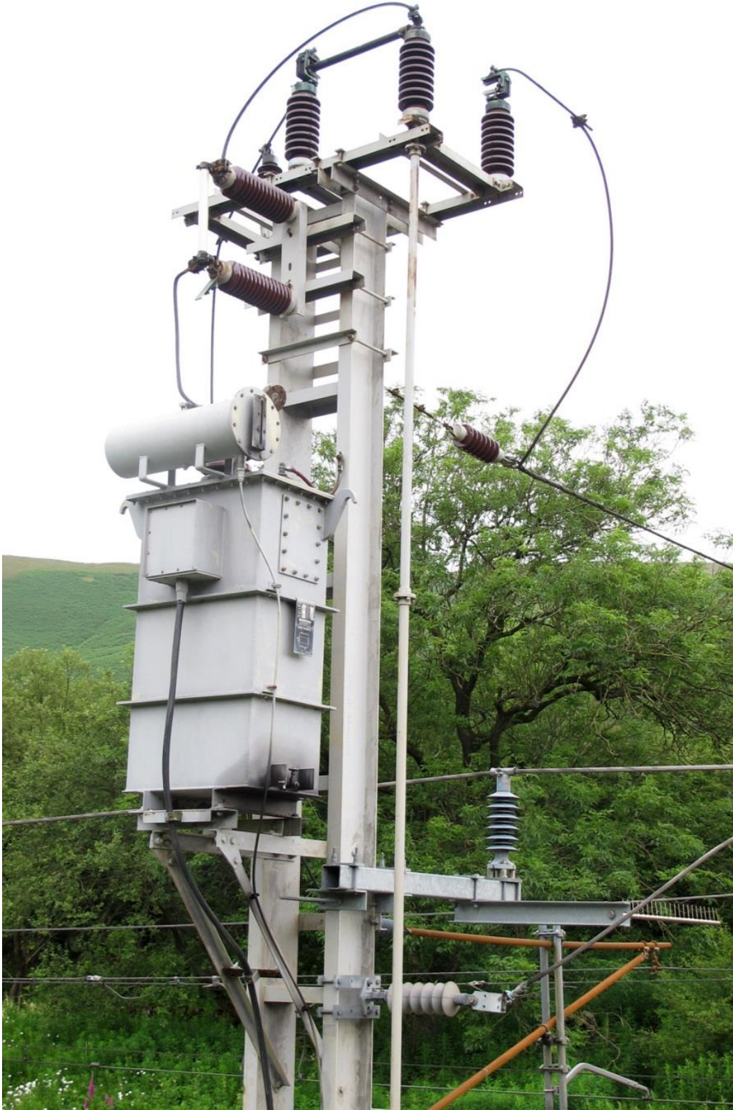
Şekil 2.16 : Katener direği üzerine asılmış 1:1 yükseltici transformatör.
