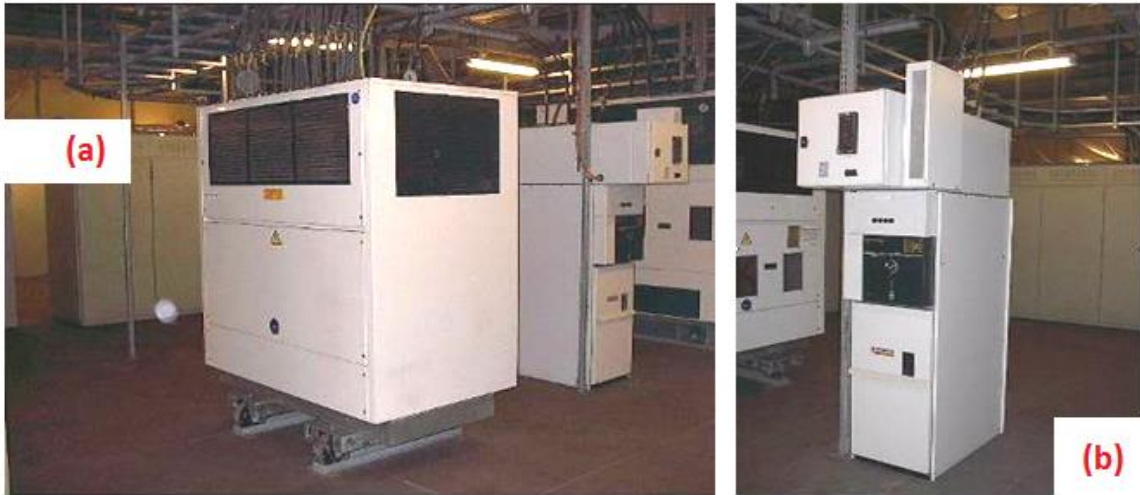
Şekil 3.10 : (a) Transfer link trafosu. (b) Transfer link panosu.
