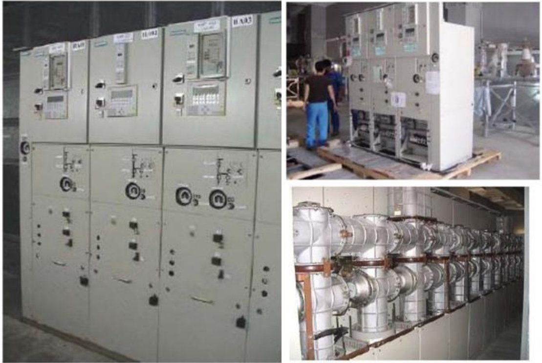
Şekil 2.19 : Gaz izoleli AC kesiciler.
