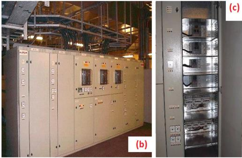
Şekil 3.7 : (a) Yardımcı güç trafosu. (b) AG dağıtım panosu. (c) AG sigortalar.
