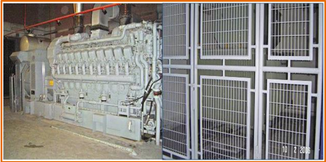
Şekil 3.3 : Acil durum dizel jeneratörü ve jeneratör trafosu.
