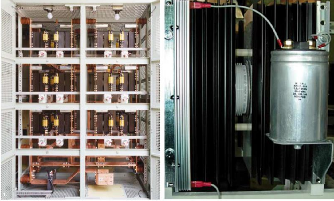
Şekil 2.3 : Doğrultucu ünitesi ve diyot.
