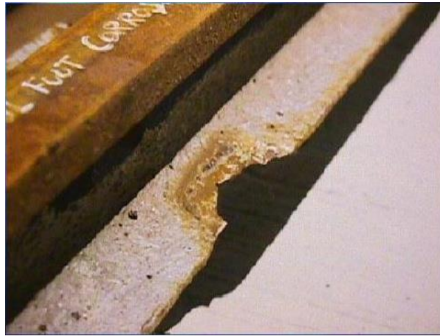
Şekil 2.46 : Korozyona uğramış raydaki demir kaybı.
