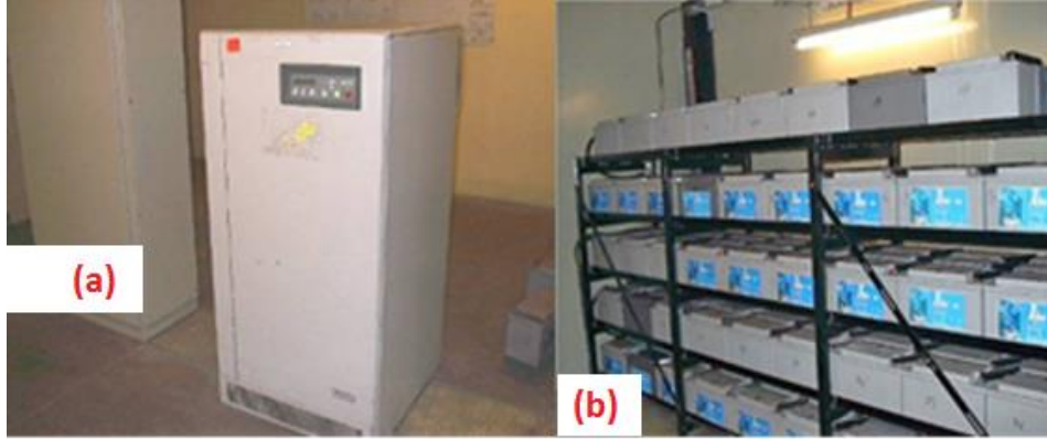
Şekil 3.9 : (a) UPS. (b) Kuru tip aküler.
