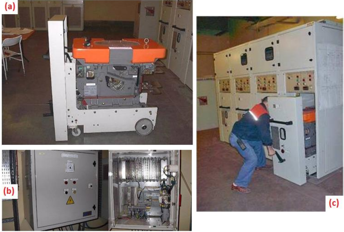
Şekil 3.6 : (a) DC kesici arabası. (b) Negatif geri dönüş koruma panosu. (c) Kesici.
