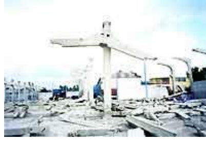
Şekil 8.5 : 1999 Kocaeli Depreminde Yıkılan Bir Prefabrik Yapı
